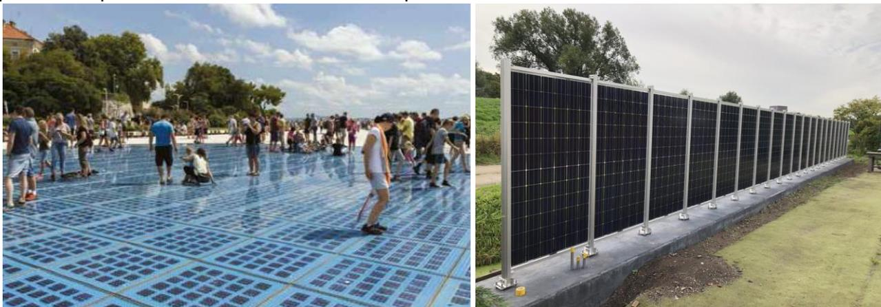
**Figura 10: Possibili riutilizzi dei pannelli: a sinistra, come pavimentazione (Fonte: Weckend S. et al., 2016); a destra, come recinzione (Fonte: <https://www.solarquotes.com>)**
