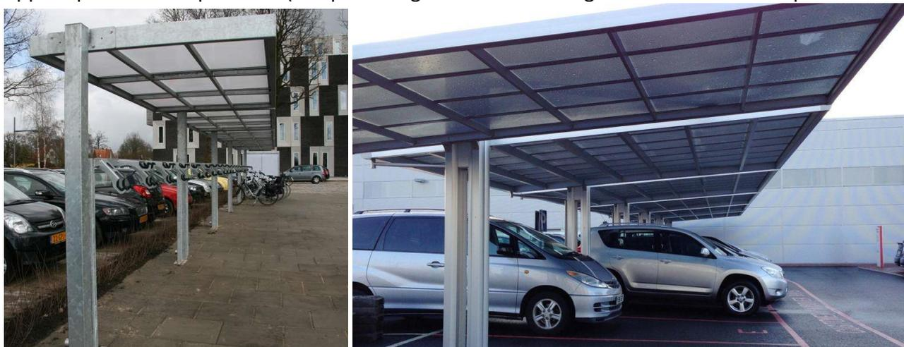
**Figura 11: possibile riuso dei tracker come sostegni per pensiline con o senza pannelli solari (Fonte: immagine a sinistra: <https://www.falco.co.uk/>; immagine a destra: <https://www.canopiesuk.co.uk/>)**
