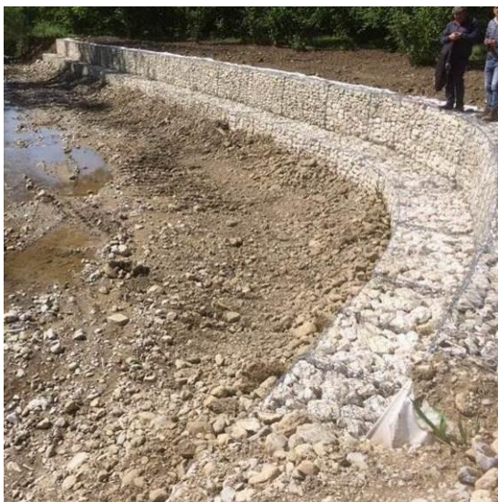
FOTO 3- Gabbionate in alveo E Schema tipo Gabbionate
