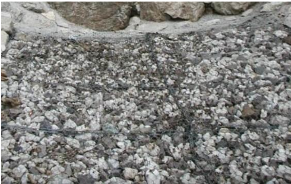
FOTO 5 - Materasso di dissipazione
