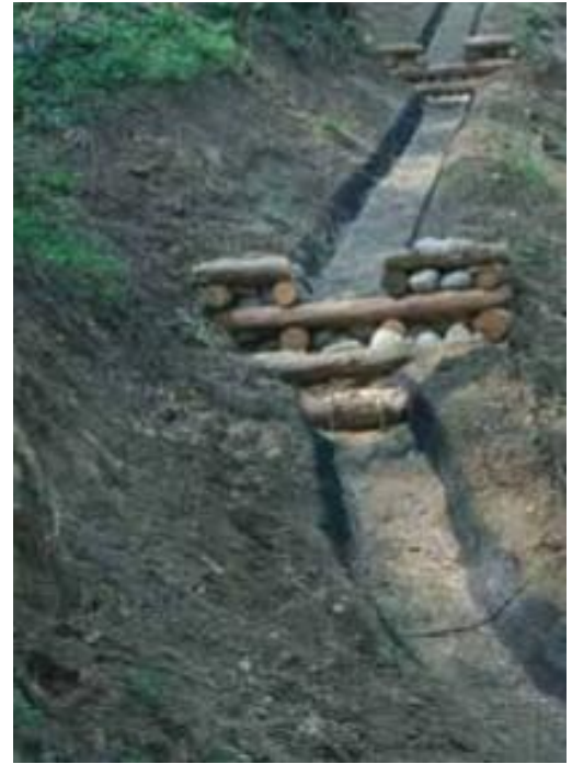
FOTO 4 - Canale con rivestimento in stuoia (dx) ed in pietrame a (sx).
