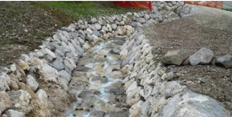
FOTO 4 - Canale con rivestimento in stuoia (dx) ed in pietrame a (sx).
