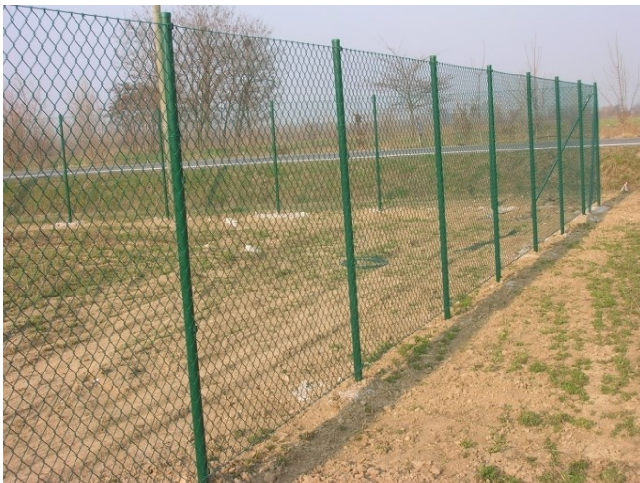
Figura 14- Tipologia di recinzione utilizzata
