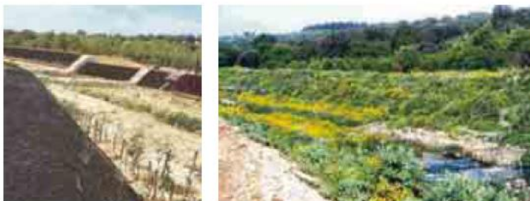
Figura 6 - Sponde di una fiumara rivestite con geostuoia tridimensionale rinforzata e rinverdita.
