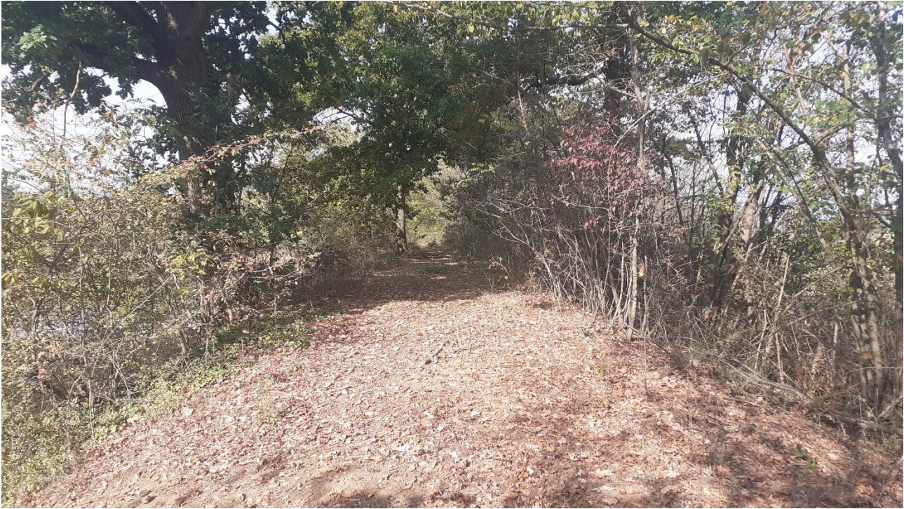
Particolare della sponda sul lato nord con i fianchi completamente rivegetati
