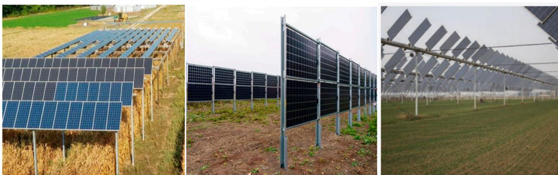
Figura 3.2: Esempi di differenti soluzioni agrivoltaiche: impianti fissi (Legambiente, 2020); moduli verticali; sistemi di inseguimento (Toledo e Scognamiglio, 2021); Sistema Agrovoltaico® ( https://remtec.energy/agrovoltaico ).
