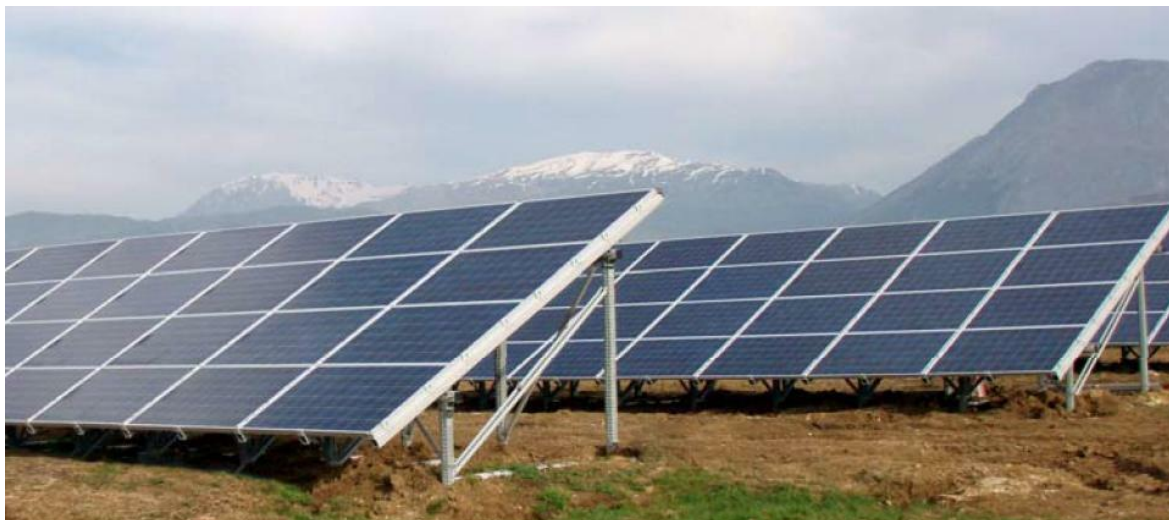
FIGURA 9: INSTALLAZIONE CON 4 MODULI IN ORIZZONTALE SU STRUTTURA FISSA
