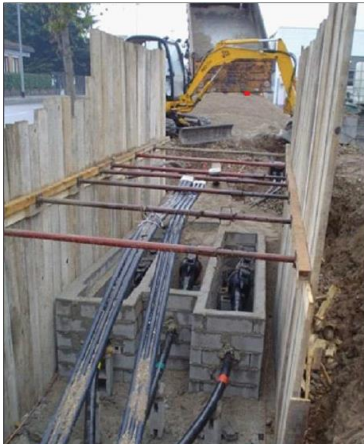
FIGURA 7: DETTAGLIO TIPOLOGICI DI BUCA GIUNTI
