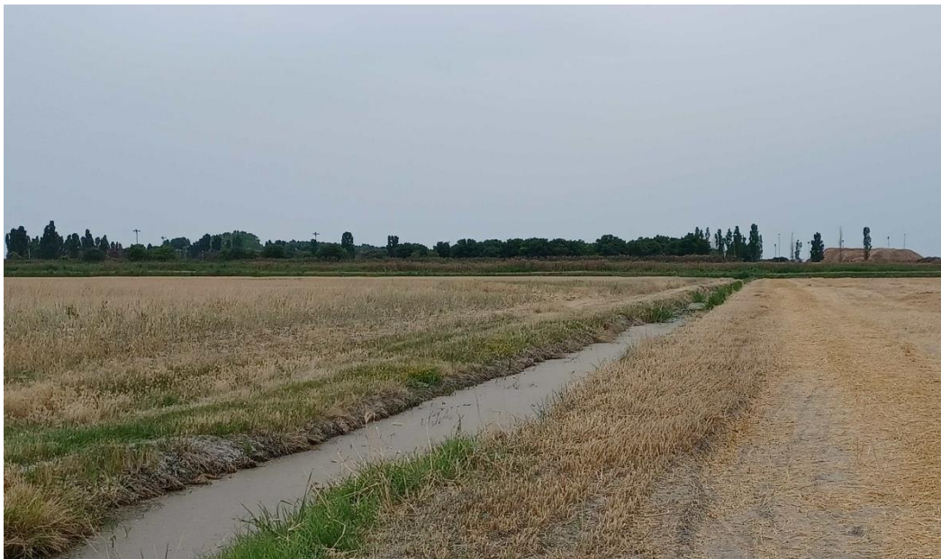
Figura 21: Canale di irrigazione/scolo in esame, vista verso Canaletta Riunita Bevignante
