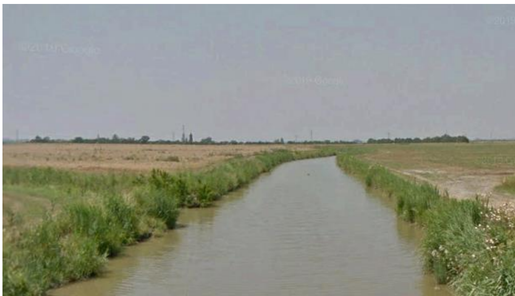
Figura 43: Sezione Scolo Forcello, vista da valle del punto in esame.
