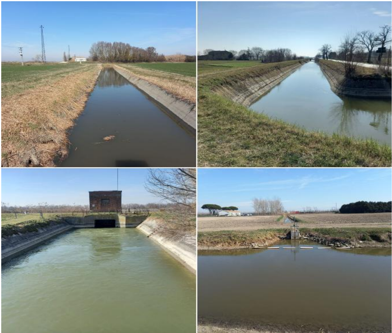
Figura 79 – Canali di raccolta gestiti dal Consorzio di bonifica
