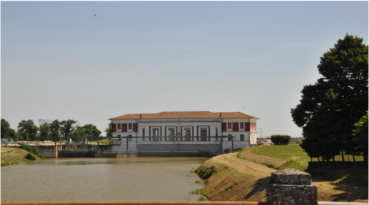
Figura 69 – Impianto idrovoro di Bando
