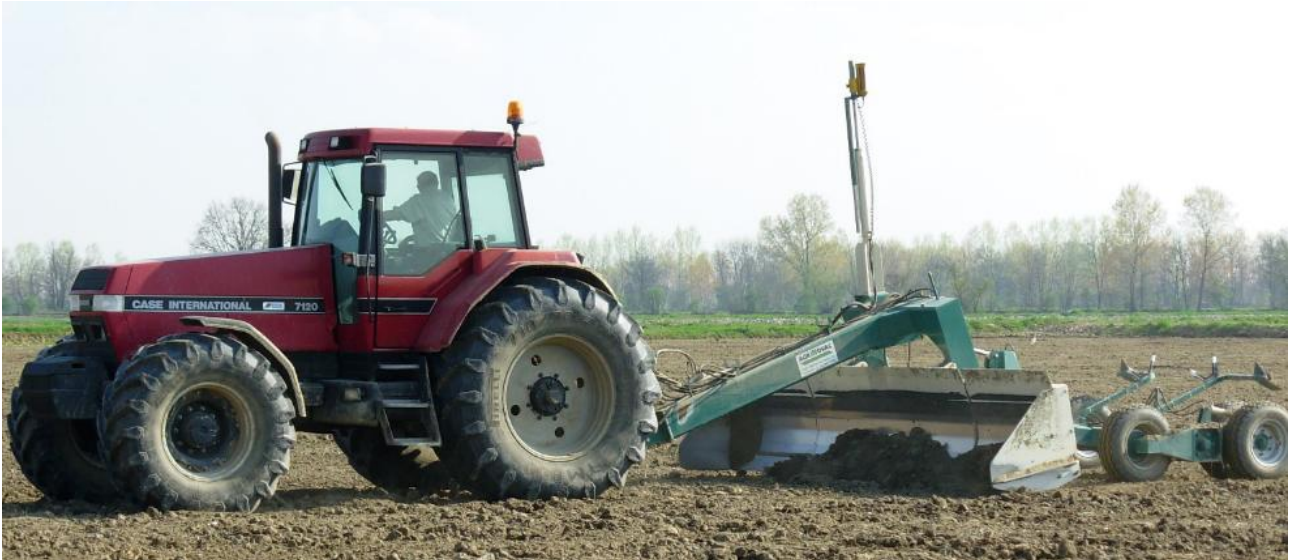
Figura 87 – Livellamento del terreno
