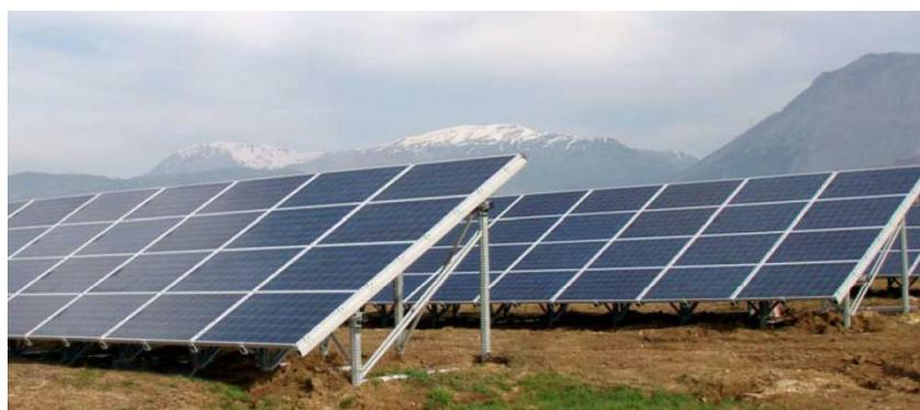
Figura 3- Installazione con 4 moduli in orizzontale su struttura fissa
