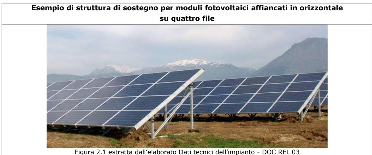
Le strutture, disposte secondo file parallele, sono tra loro distanziate di 3 metri, per evitare effetti di reciproco ombreggiamento e consentire anche il passaggio dei piccoli mezzi necessari per effettuare la manutenzione.
