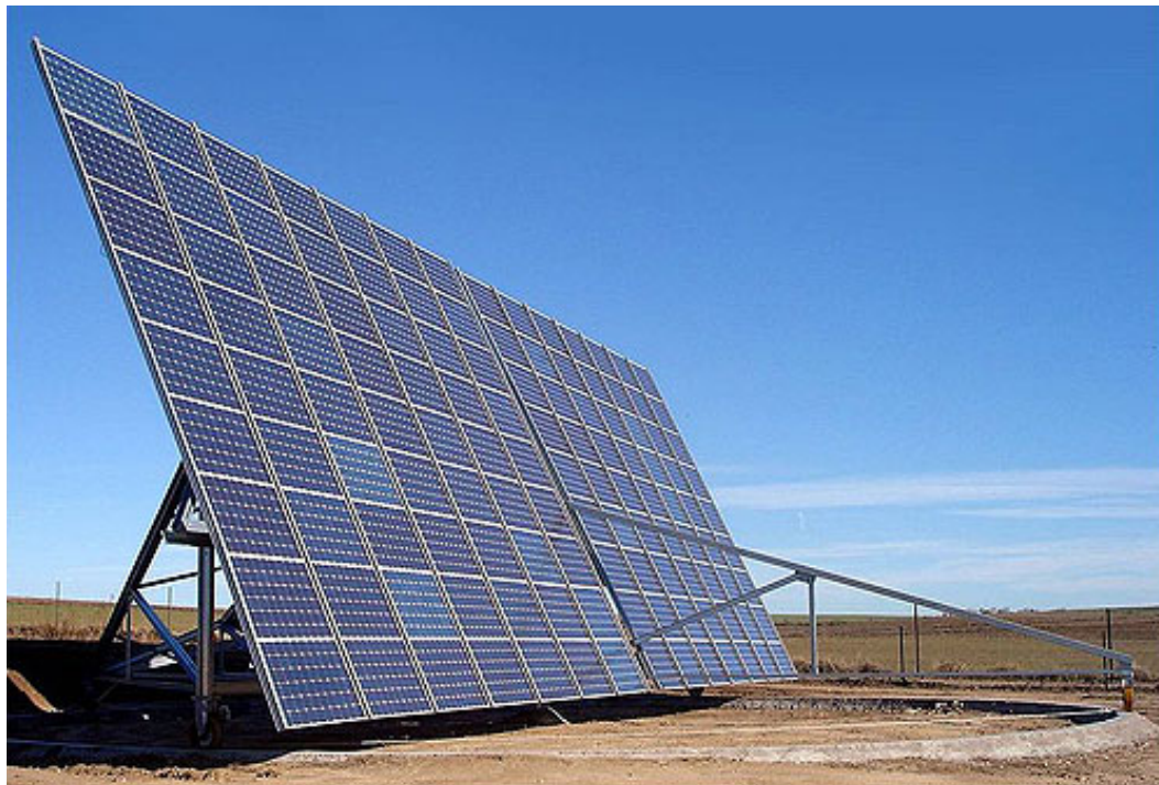
Figura 7 - Inseguitore biassiale "tilt – rollio"
