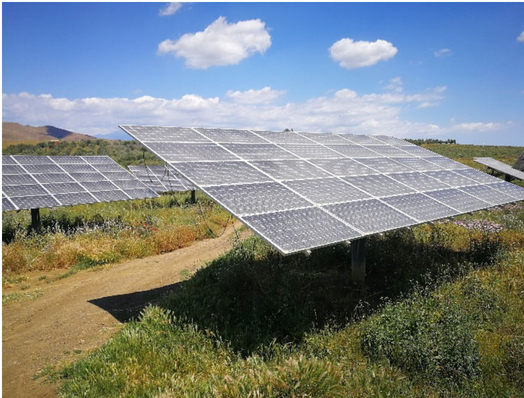
Figura 6 - Inseguitore biassiale "azimut-elevazione"
