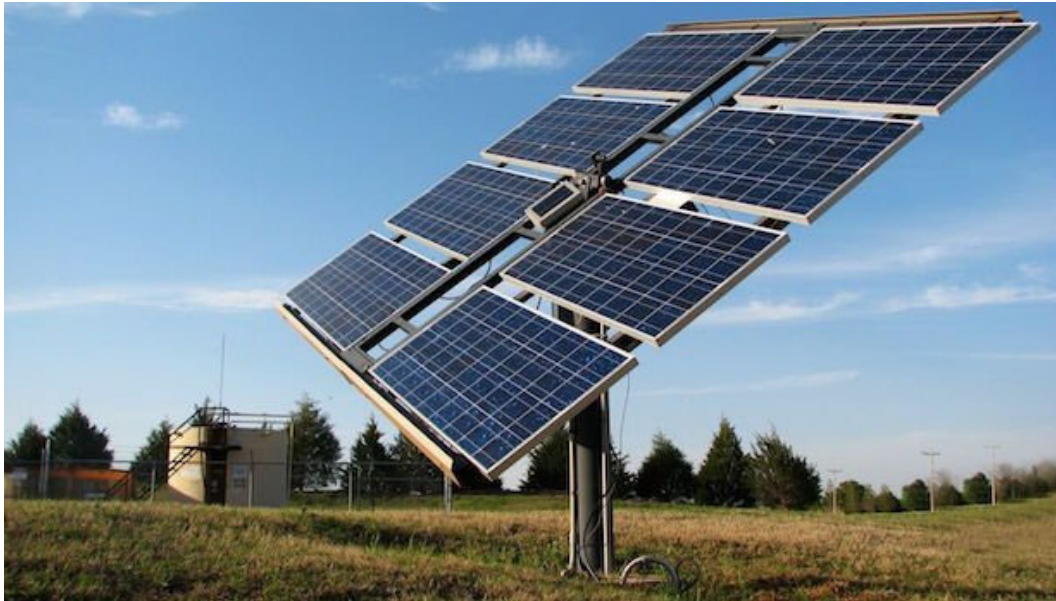
Figura 41 - Inseguitori monoassiali di "azimut"
