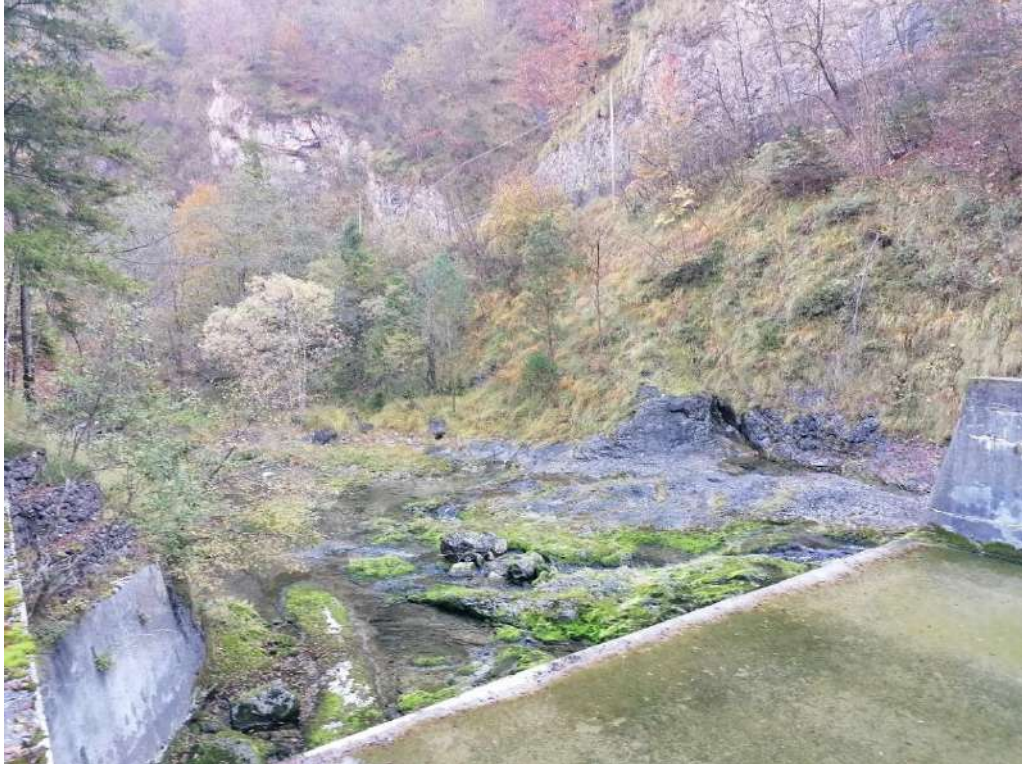
Foto 6 Area di cantiere di valle, dove verrà realizzata la nuova vasca dissipatrice di progetto; in destra e sinistra idrografica primitive aree boscate; l'alveo roccioso è escluso dalla classificazione a bosco vista la larghezza (ambito escluso anche dal PIF).
