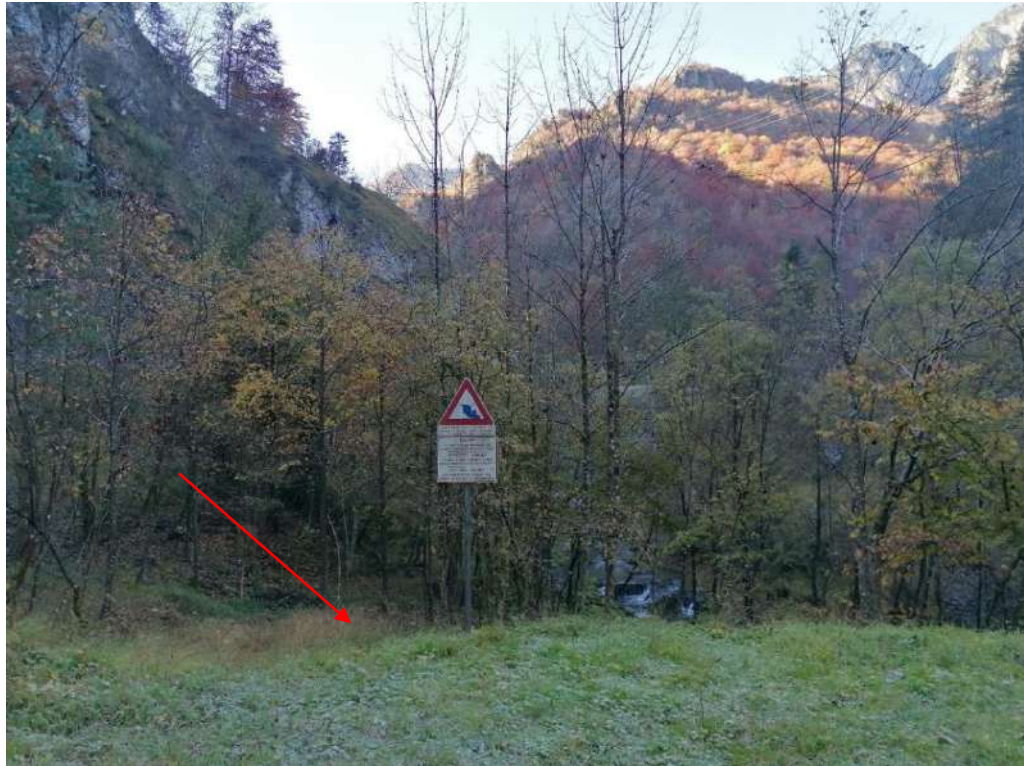
Foto 17 la pista di cantiere parte nei pressi dell'area A.2
