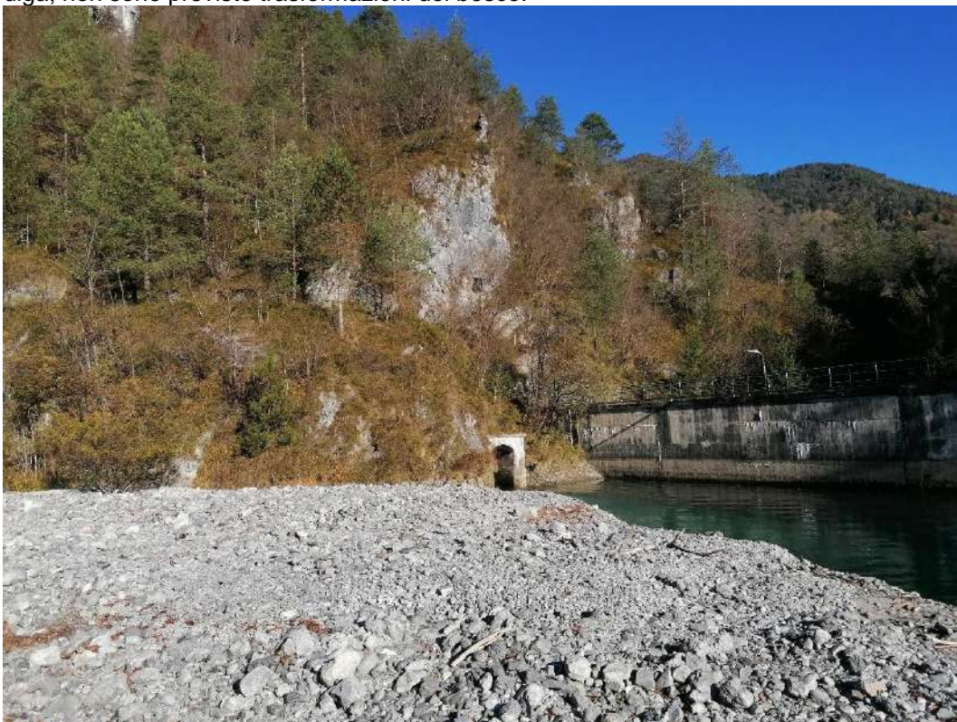
Foto 14 vista dell'area direttamente a monte della diga dove si installerà la gru necessaria per realizzare i lavori; la gru sarà posizionata al margine della ripida scarpata boscata, ma non si prevedono trasformazioni del bosco.
