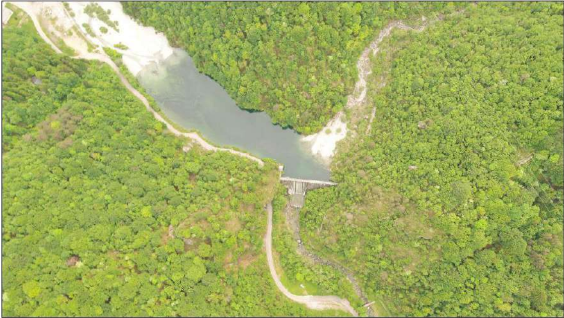
Figura 4 L'area di intervento rilevata col drone
