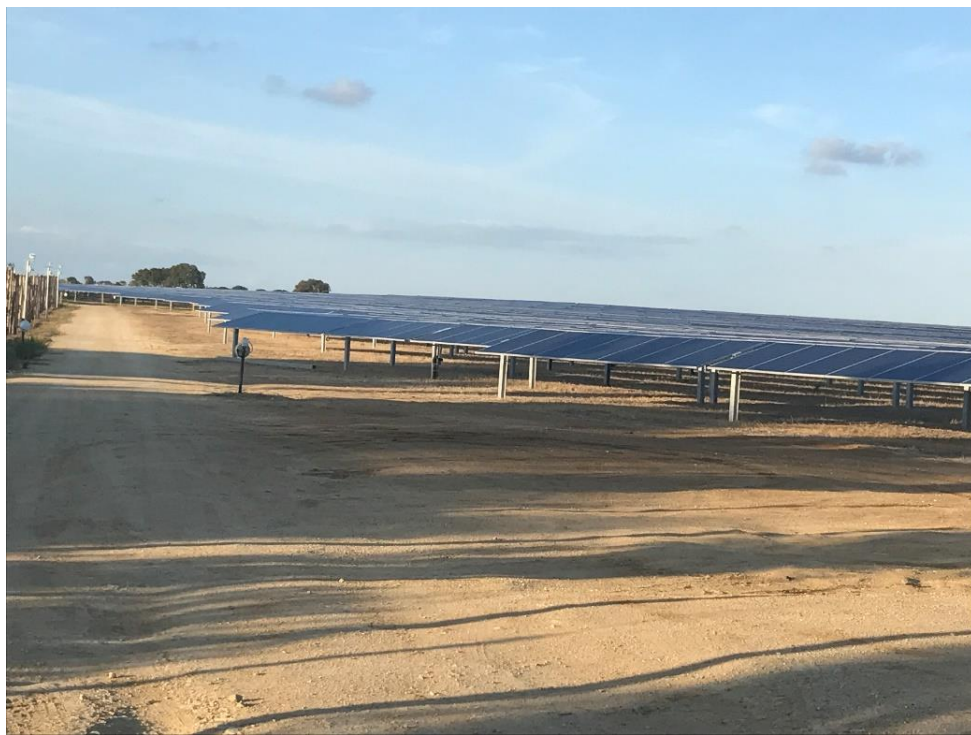
Figura 5 – impianto con viabilità interna
