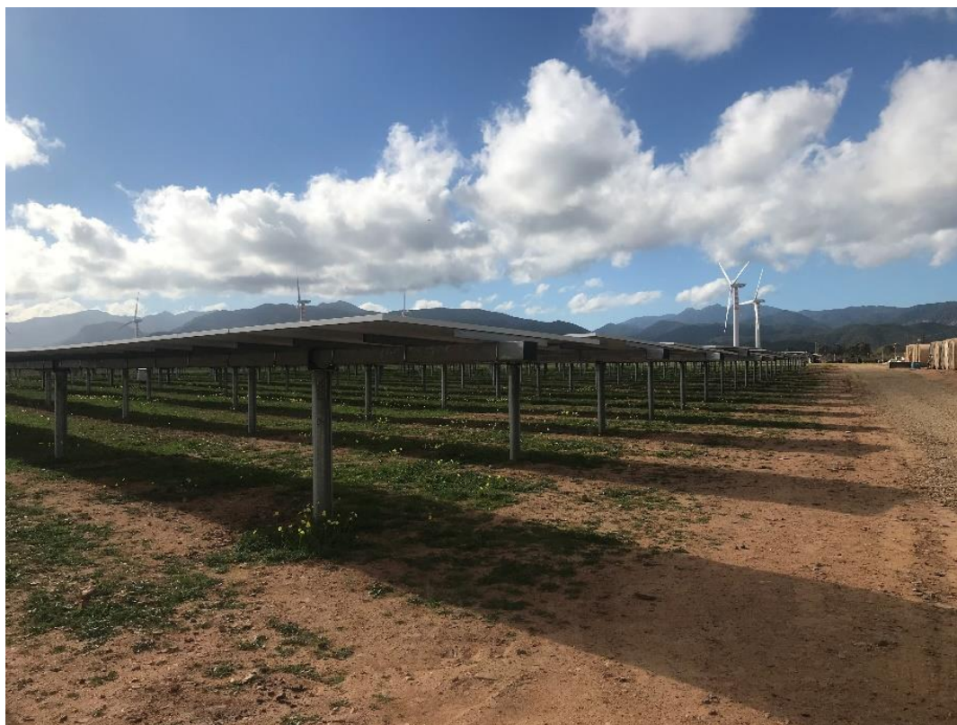
Immagine dei tracker in un impianto limitrofo già realizzato.
