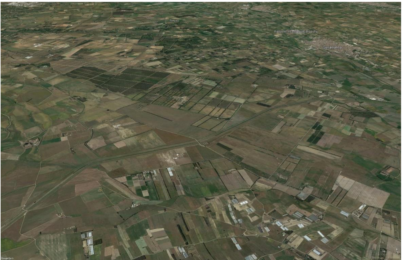
Vista generale dell'area di impianto
