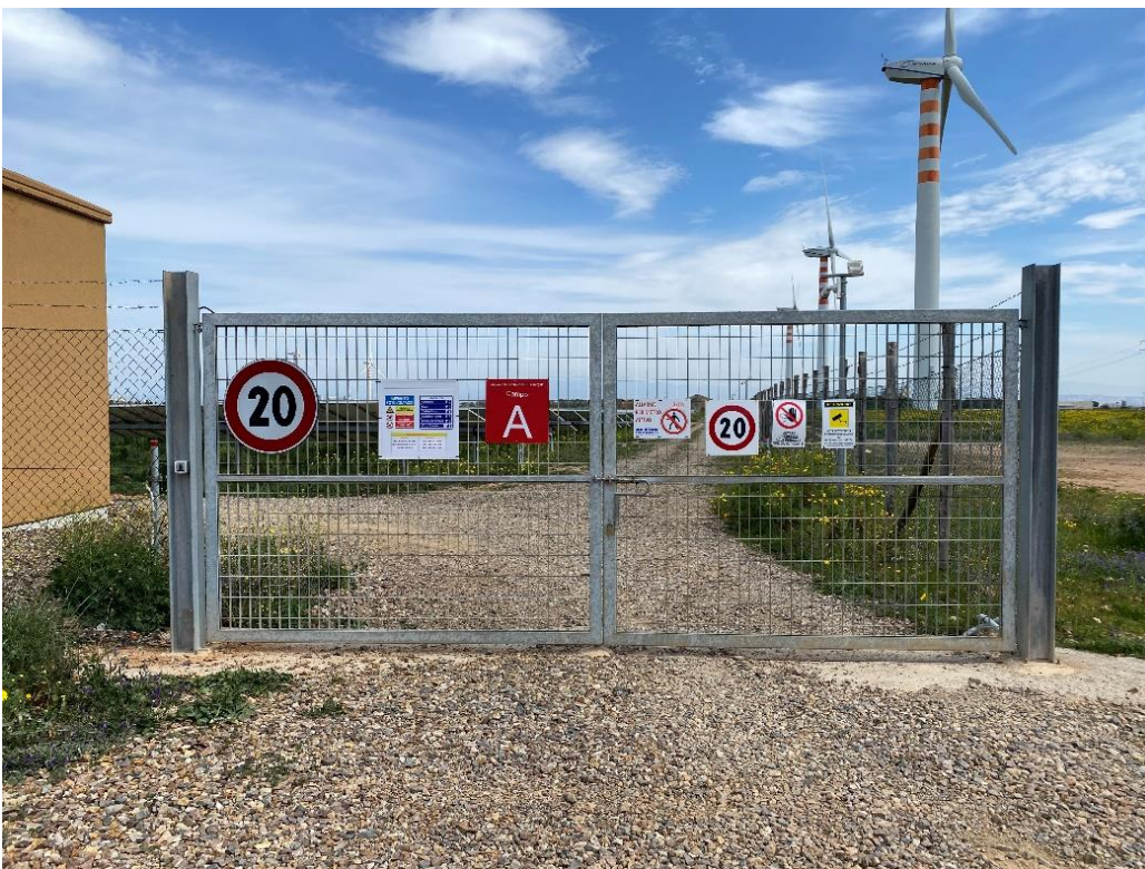
Immagine 1.10: Tipologia cancello d'ingresso
