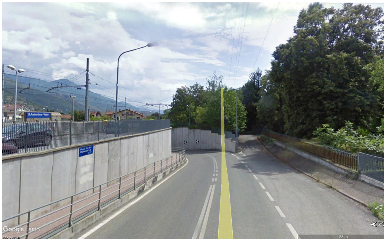
Foto 1: Viabilità di accesso all'area di cantiere
