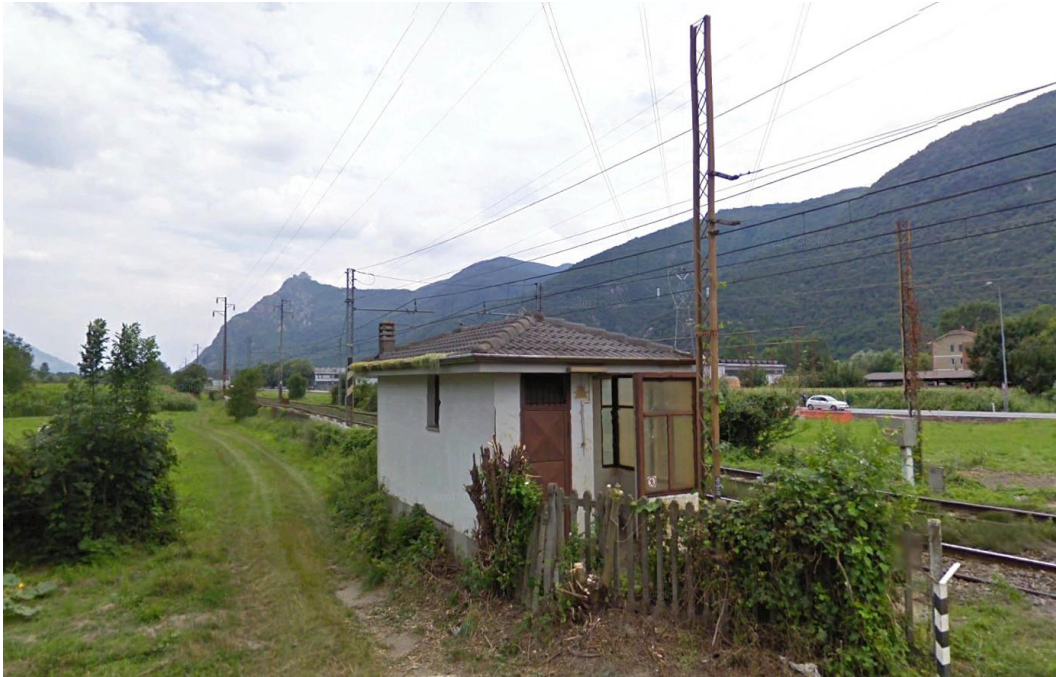
Figura 18 – Casello ferroviario oggetto di demolizione
