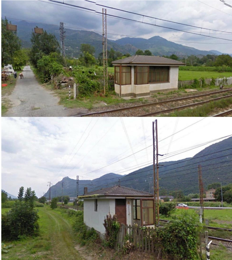
Figura 4-12 Casello ferroviario oggetto di demolizione
