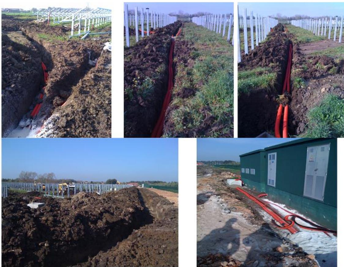
Dalla cabina di parallelo posta nel Settore Sud avrà origine il cavidotto di collegamento tra l'impianto e la Stazione utente AT/MT. Tale cavidotto verrà realizzato tramite l'impiego di 4 terne di cavi Al del tipo ARE4H5EX di sezione pari a 240 mmq. Il tracciato del cavidotto, di lunghezza complessiva pari a circa 10,8 km, prevede che la posa avvenga in massima parte seguendo il percorso della viabilità esistente. Per maggiori dettagli si rimanda ai relativi elaborati di progetto.
