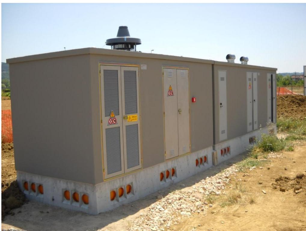
Le cabine di trasformazione disporranno di tre locali, di cui uno adibito all'installazione dei quadri di parallelo BT, uno per l'ubicazione del trasformatore ed uno dedicato ai quadri MT.
