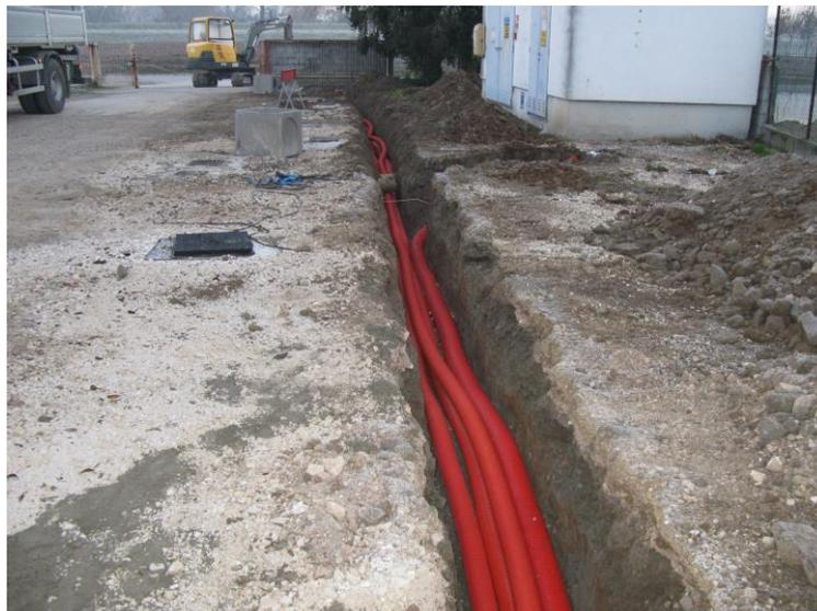
Dopo gli opportuni tracciamenti, la prima fase consiste nel compiere le operazioni di scavo mediante pala meccanica. Successivamente vengono posizionati i cavidotti attraverso i quali saranno poi stesi i diversi cavi necessari. Infine si procede al ricoprimento con strato di sabbia e nastro di segnalazione, per poi completare il rinterro con materiale proveniente dallo scavo.
