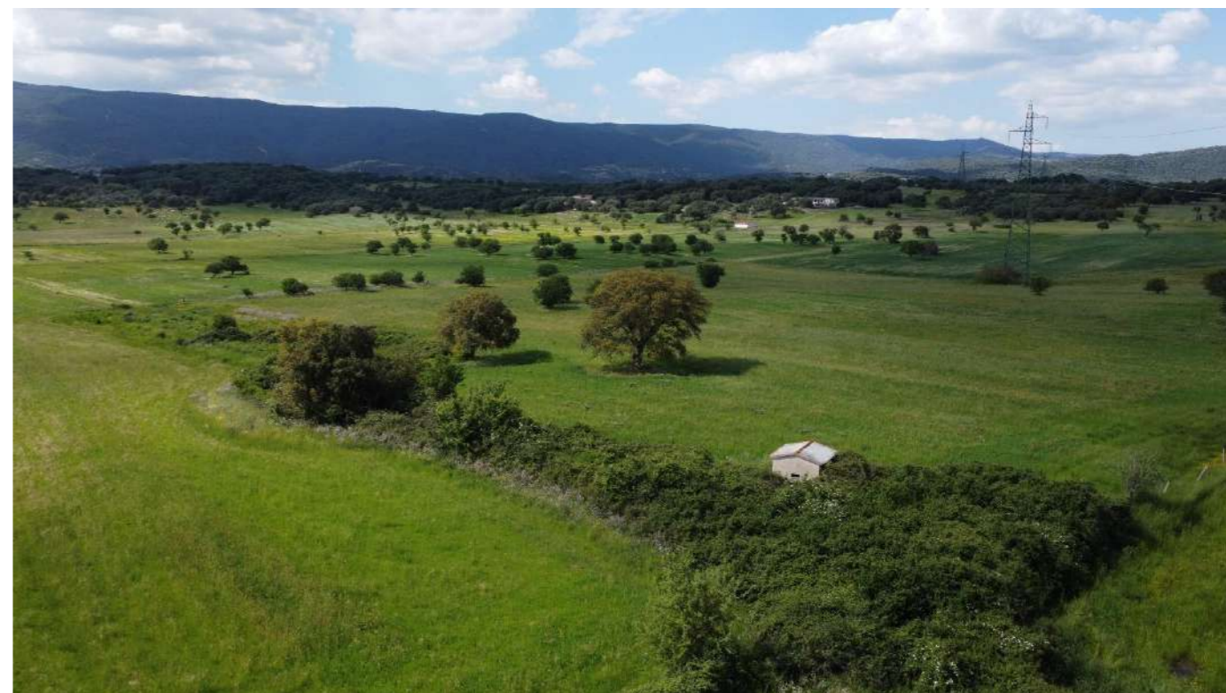
Foto 38 – Volo drone 01 – Impianto FV area Nord, limite sud-est
