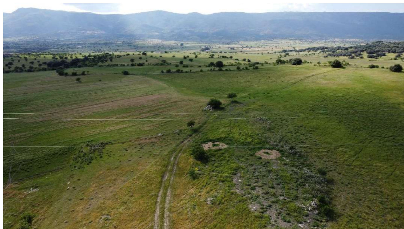
Foto 56 – Volo drone 03 – Impianto FV area Sud, limite sud-ovest
