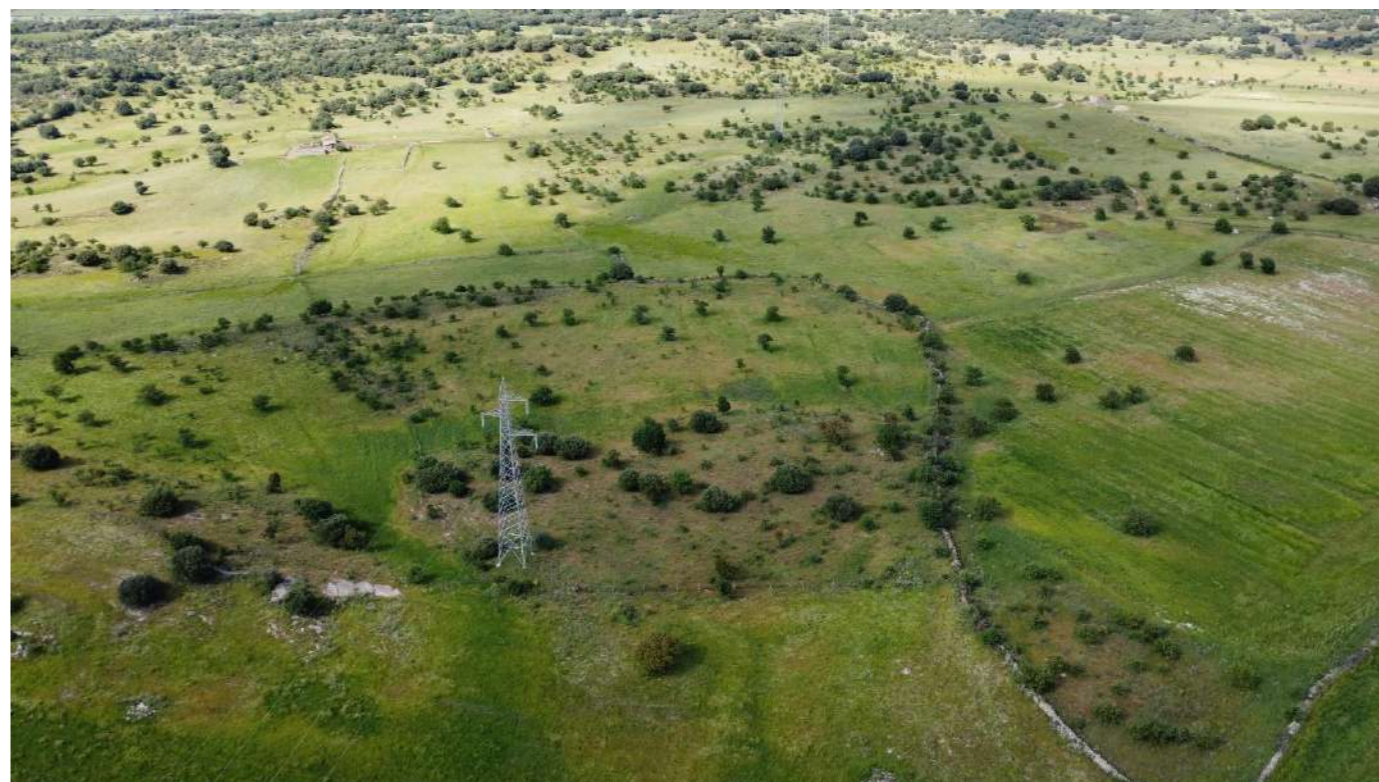
Foto 58 – Volo drone 03 – Impianto FV area Sud, limite sud-ovest
