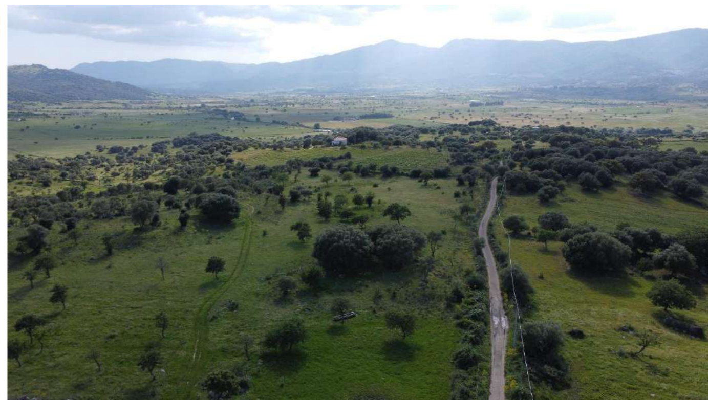
Foto 62 – Volo drone 04 – Impianto FV area Sud, limite nord
