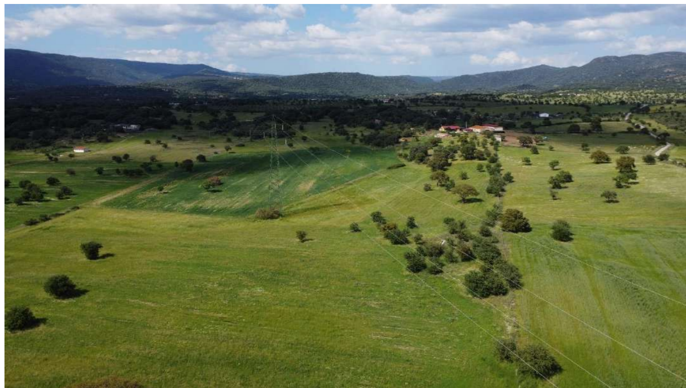
Foto 43 – Volo drone 01 – Impianto FV area Nord, limite sud-est
