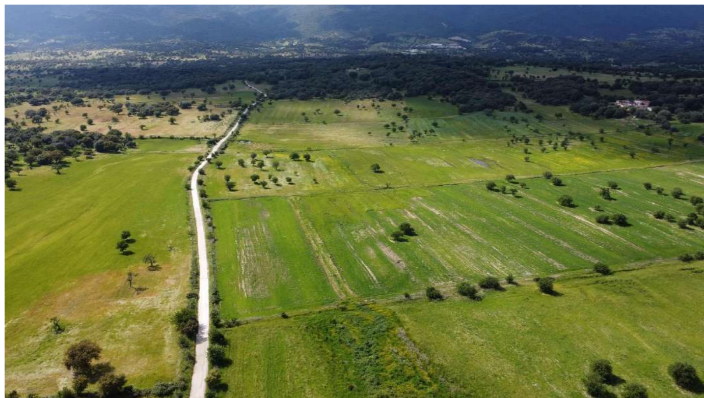
Foto 41 – Volo drone 01 – Impianto FV area Nord, limite sud-est
