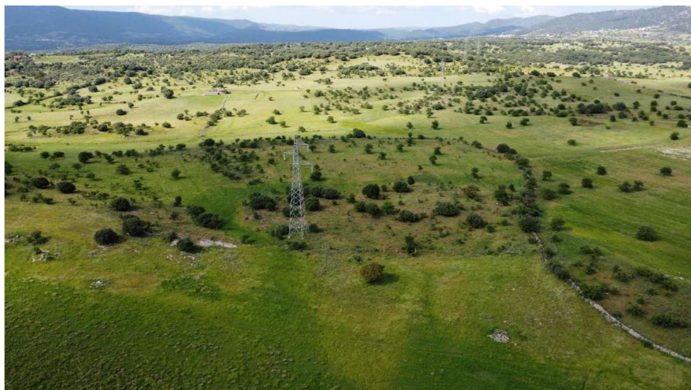
Foto 59 – Volo drone 03 – Impianto FV area Sud, limite sud-ovest
