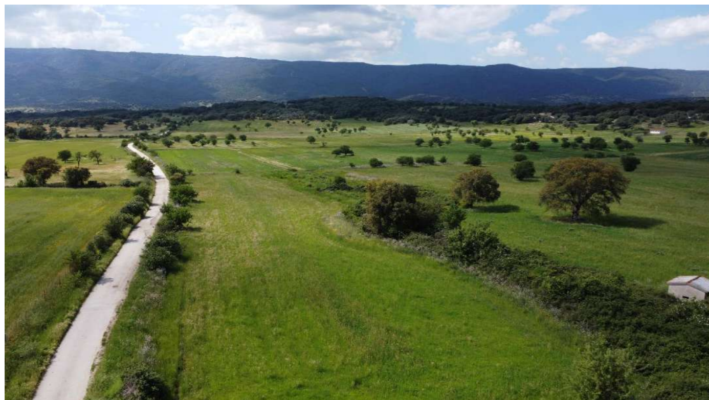
Foto 37 – Volo drone 01 – Impianto FV area Nord, limite sud-est
