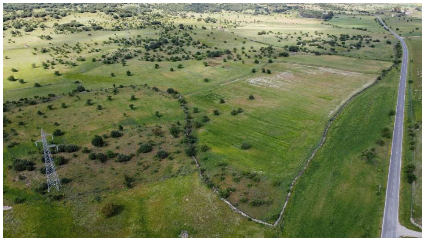
Foto 57 – Volo drone 03 – Impianto FV area Sud, limite sud-ovest
