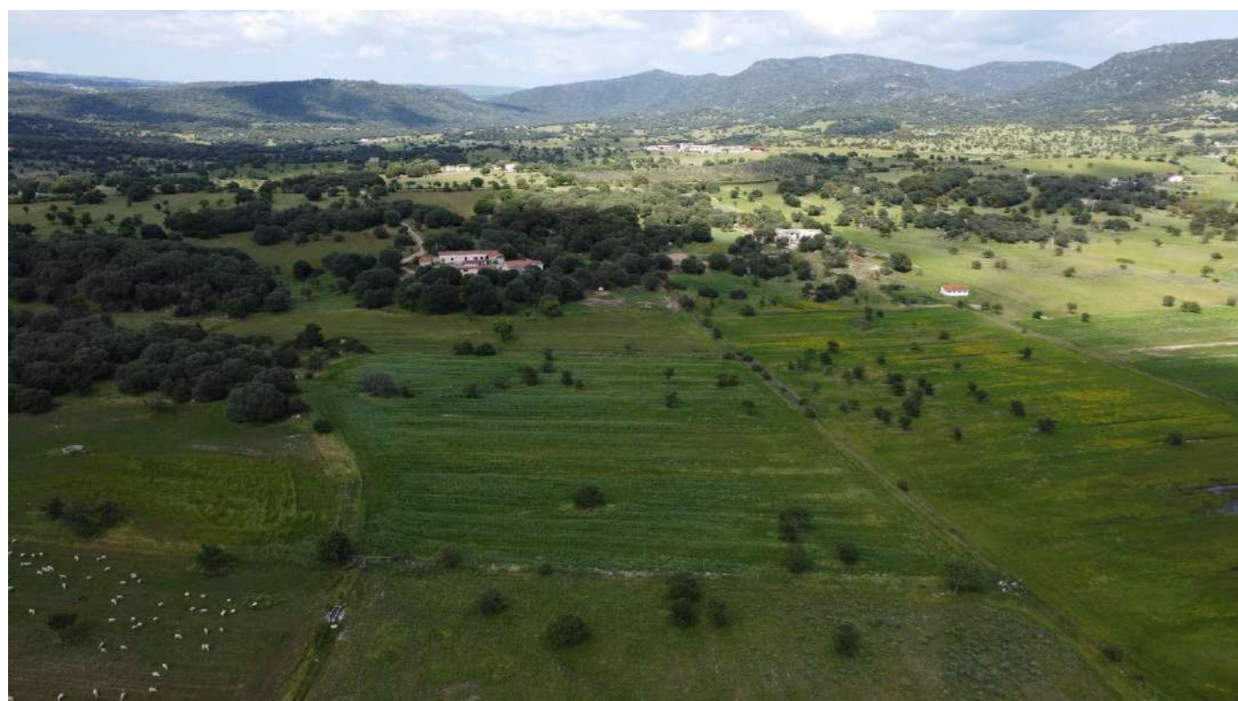
Foto 51 – Volo drone 02 – Impianto FV area Nord, limite sud-ovest
