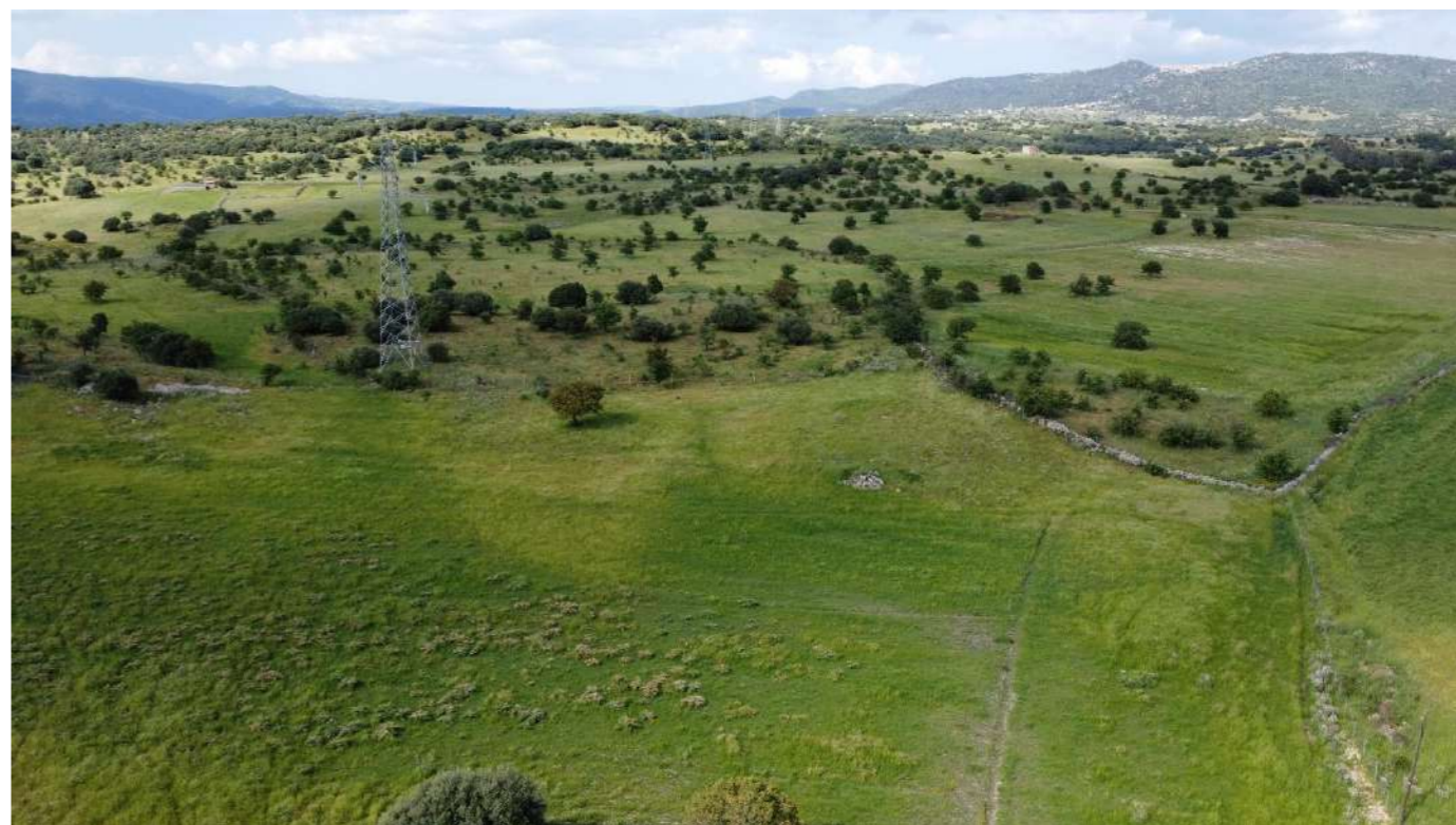
Foto 54 – Volo drone 03 – Impianto FV area Sud, limite sud-ovest
