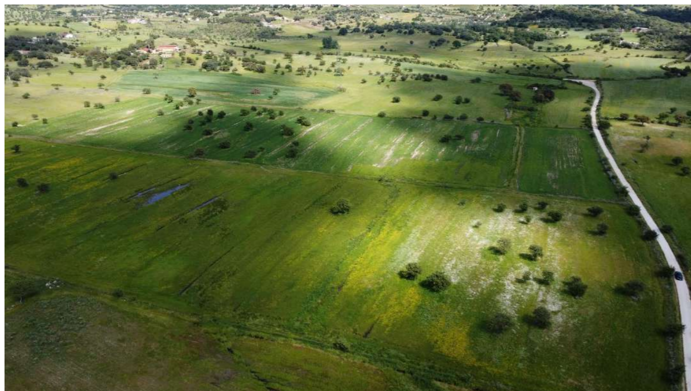
Foto 49 – Volo drone 02 – Impianto FV area Nord, limite sud-ovest
