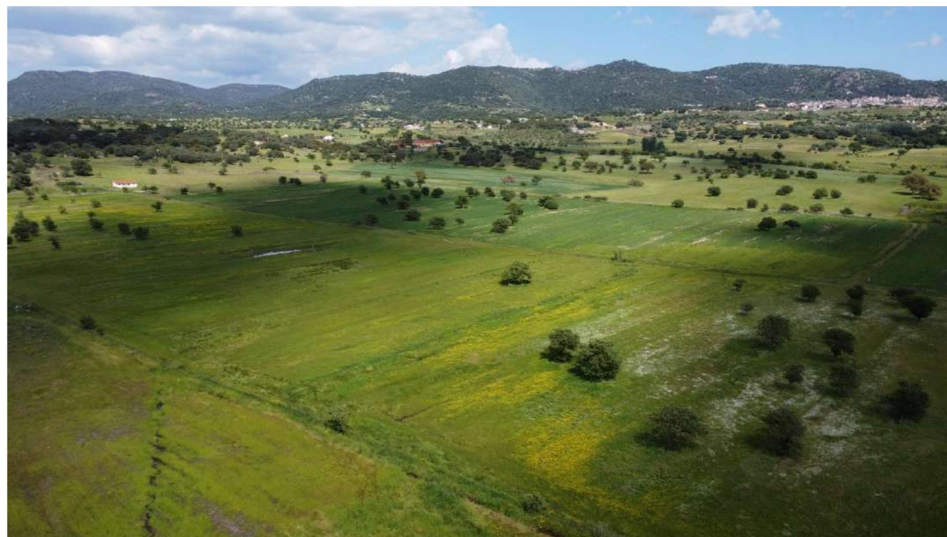
Foto 46 – Volo drone 02 – Impianto FV area Nord, limite sud-ovest
