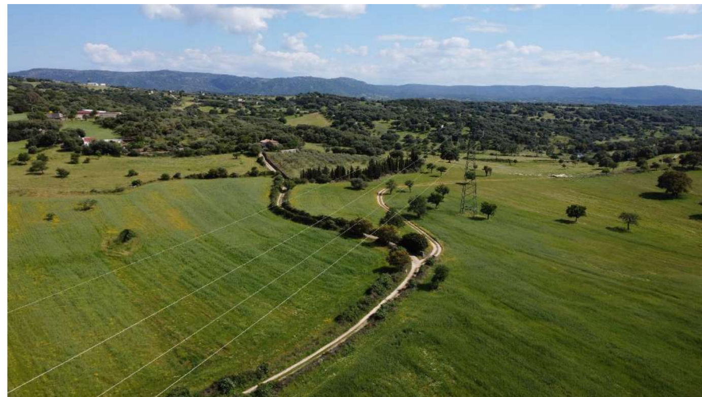
Foto 44 – Volo drone 01 – Impianto FV area Nord, limite sud-est
