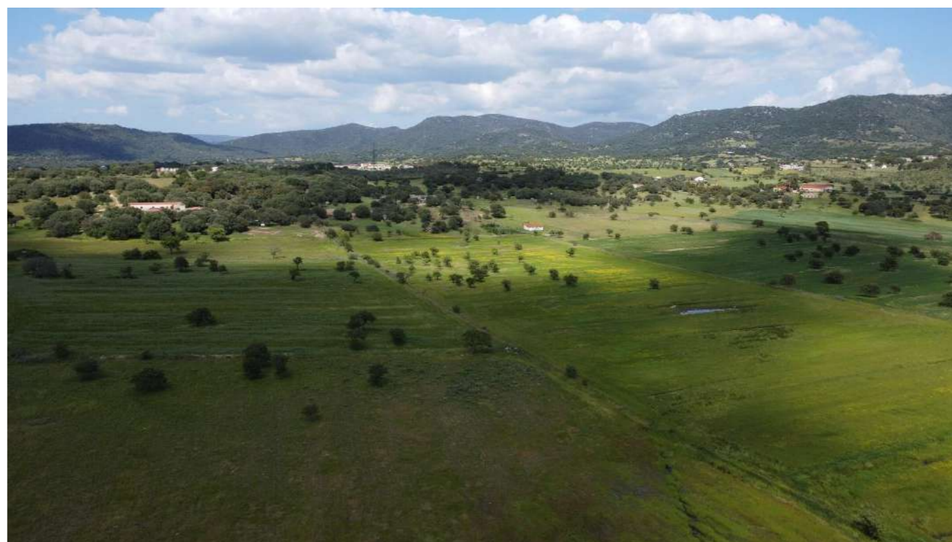
Foto 48 – Volo drone 02 – Impianto FV area Nord, limite sud-ovest
