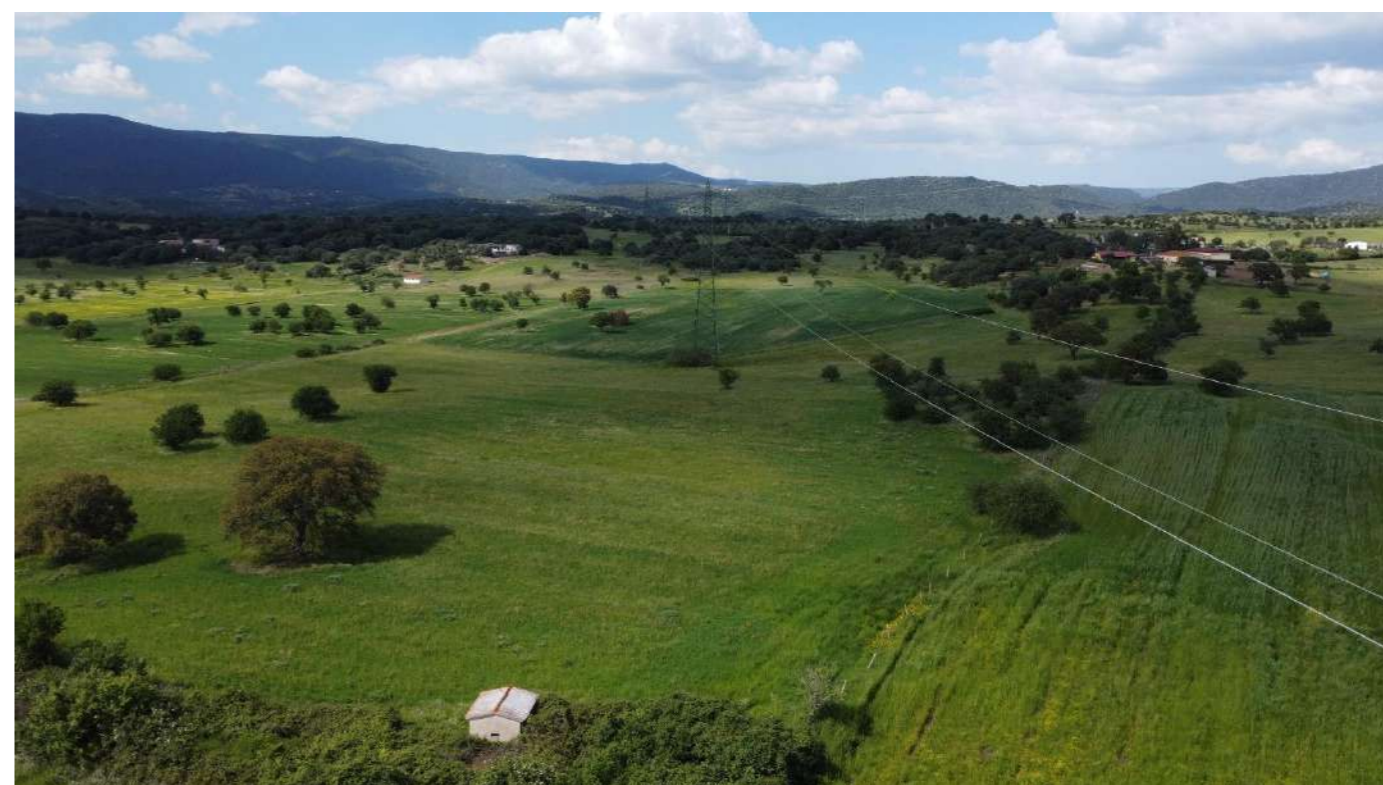
Foto 40 – Volo drone 01 – Impianto FV area Nord, limite sud-est
