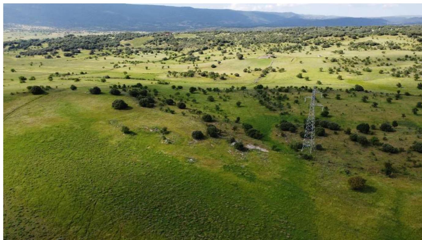
Foto 60 – Volo drone 03 – Impianto FV area Sud, limite sud-ovest
