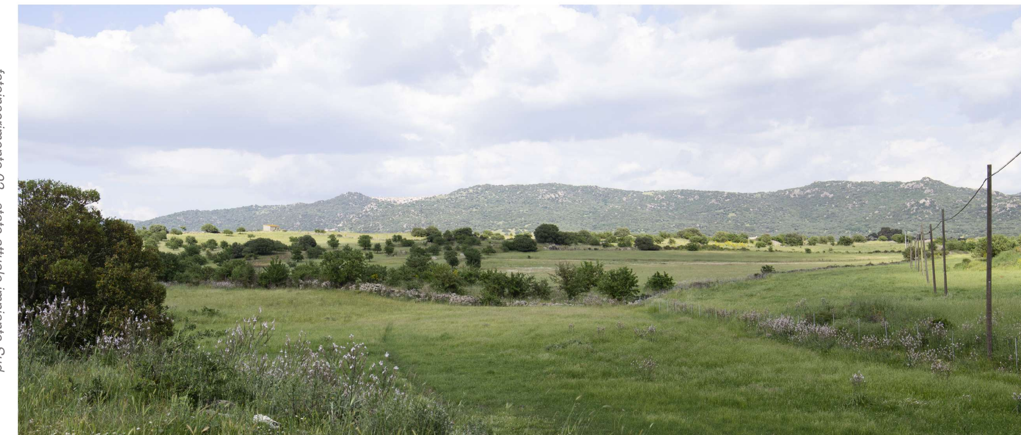
fotoinserimento 02 - stato attuale impianto Sud
