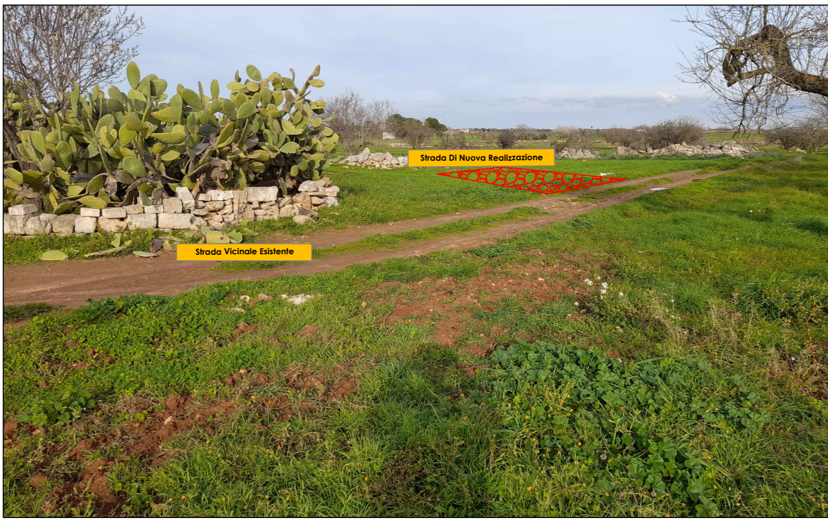
Ingresso SC-3-I3 (40.404313°N 17.807310°E) Nuova Viabilità Lunghezza 5 M Larghezza 3,5 m
