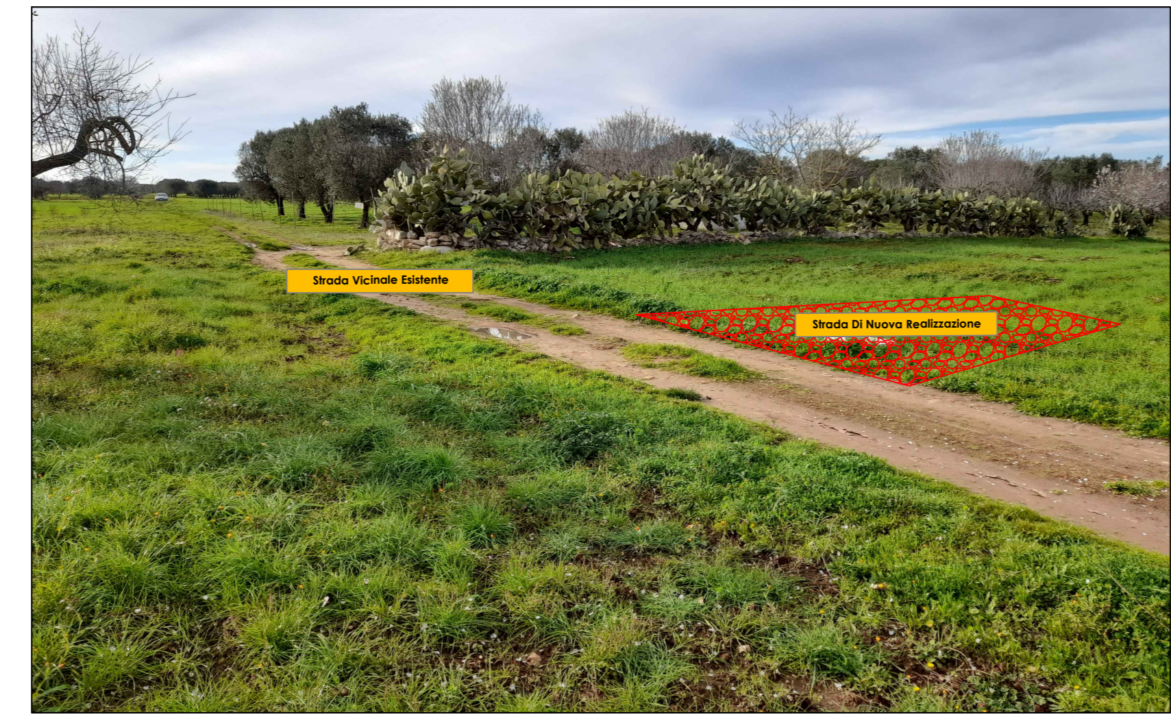
Ingresso SC-3-I3 (40.404313°N 17.807310°E) Nuova Viabilità Lunghezza 5 M Larghezza 3,5 m
