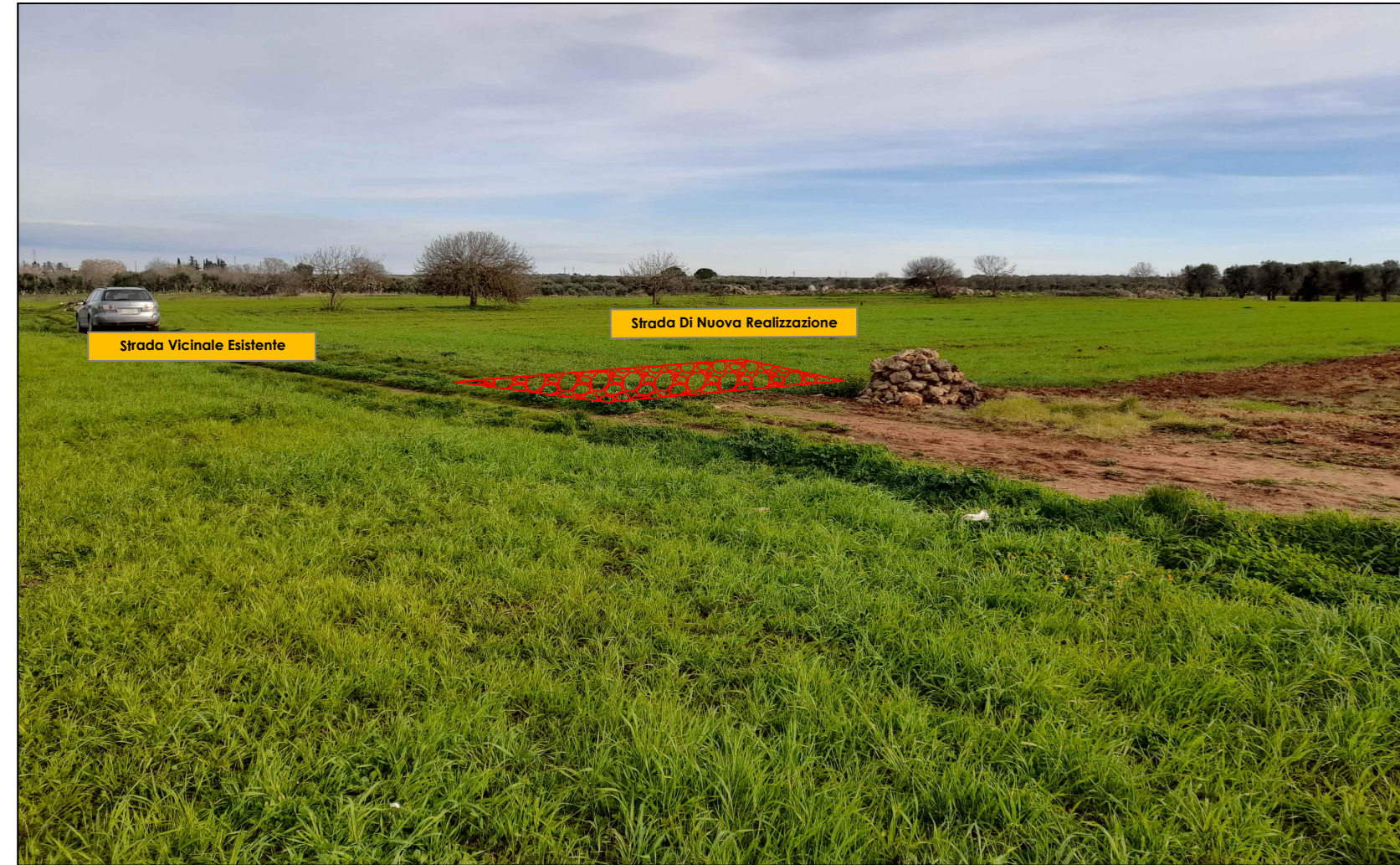
Ingresso SC-3-I5 (40.404360°N 17.805353°E) Nuova Viabilità Lunghezza 5 M Larghezza 3,5 m
