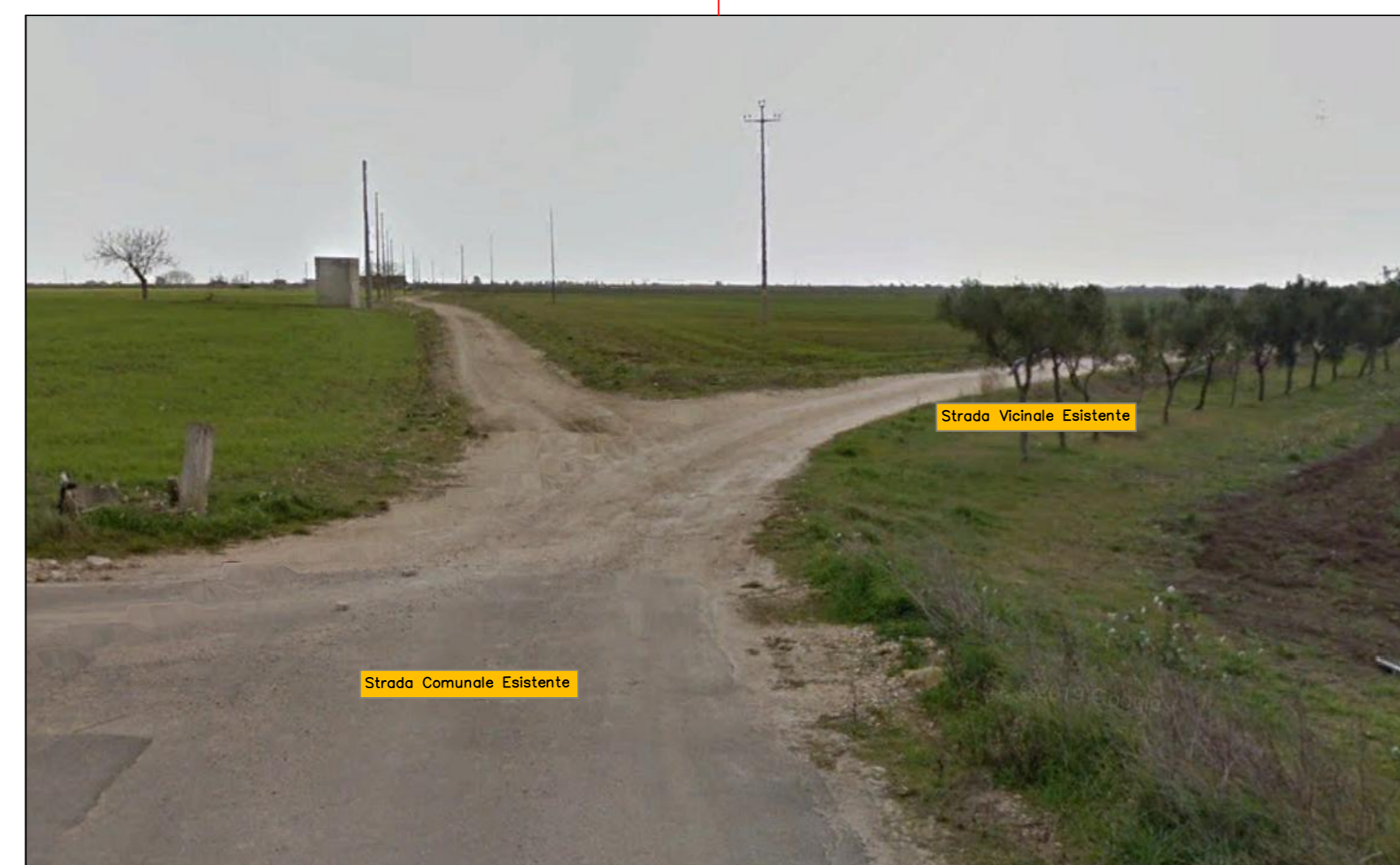
Ingresso Strada Vicinale Verso SC-4 (Da Strada Comunale Esistente)
