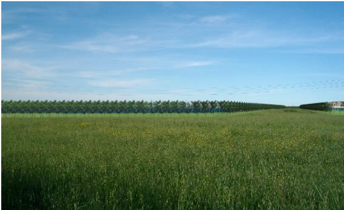
Figura 9.58: Rappresentazione delle Visuali Critiche 12 SC-4 (Impianto con mitigazione)
