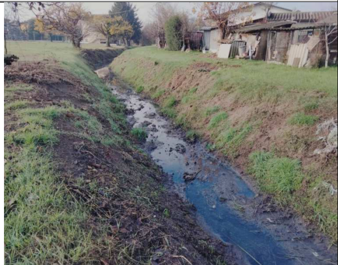
FOTO DELLA STAZIONE ASU-OC-SB-014
