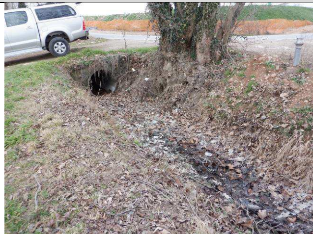
FOTO DELLA STAZIONE ASU-OC-SM-010
