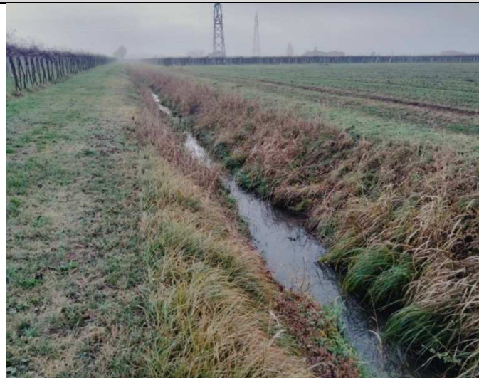
FOTO DELLA STAZIONE ASU-OC-SB-004
