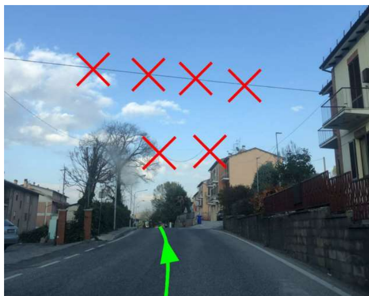
Figura 9 Esempio rimozione cavi elettrici e del telefono
