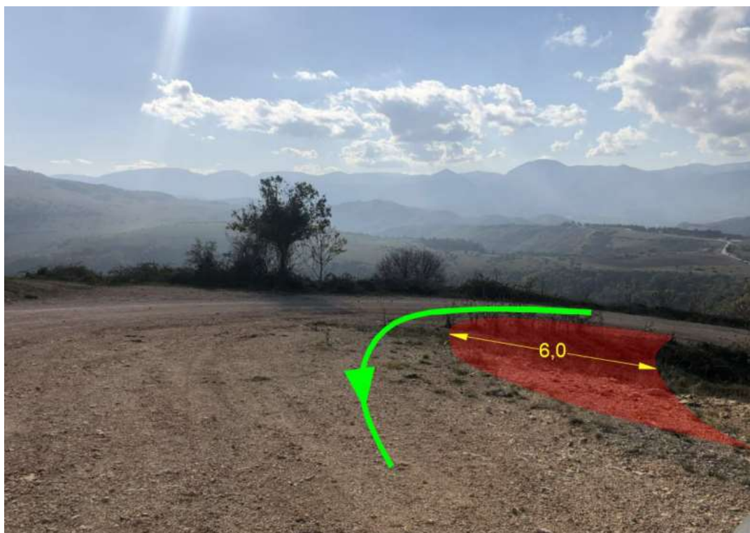
Figura 8 Esempio allargamento curva stretta
