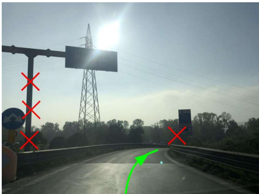
Figura 4 Esempio rimozione segnaletica stradale verticale
