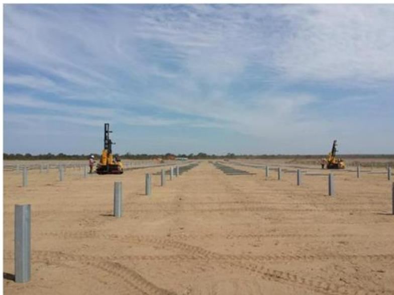
Figura 12. Fase di infissione dei pali con profilo in acciaio zincato (fonte Convert)
