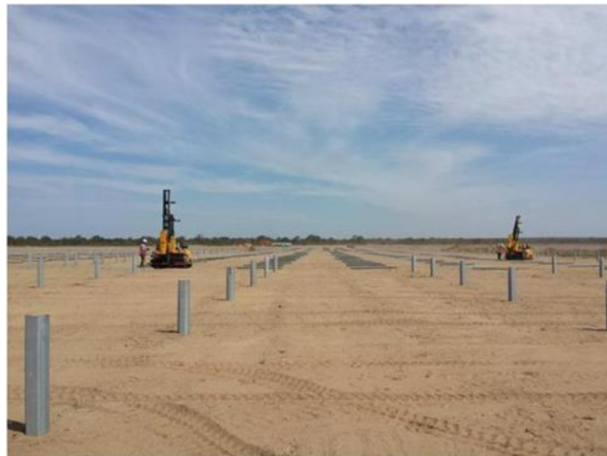
Figura 3.8 Fase di infissione dei pali con profilo in acciaio zincato (fonte Convert)
