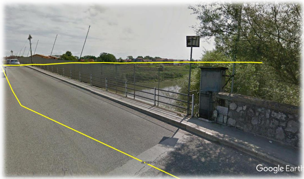
Figura 16. Dettaglio percorso cavidotto MT in posizione 41°04'28.17"N 14°01'41.34"E
