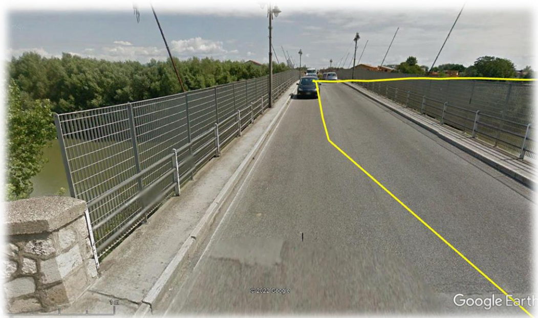
Figura 15. Dettaglio percorso cavidotto MT in posizione 41°04'28.42"N 14°01'41.12"E
