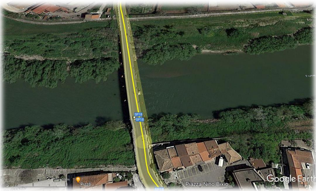
Figura 14. Dettaglio percorso cavidotto MT in posizione 41°04'26.07"N 14°01'43.20"E
