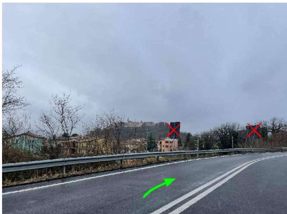
Figura 6 Esempio rimozione segnaletica stradale verticale
