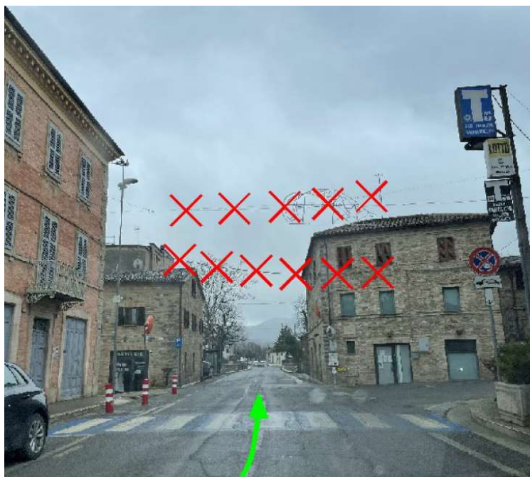
Figura 11 Esempio rimozione cavi elettrici e del telefono
