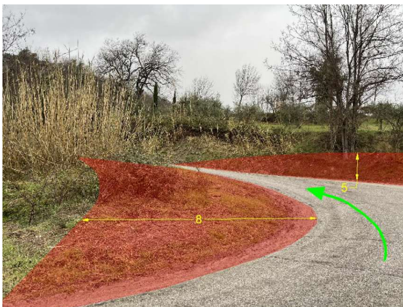
Figura 10 Esempio allargamento curva stretta
