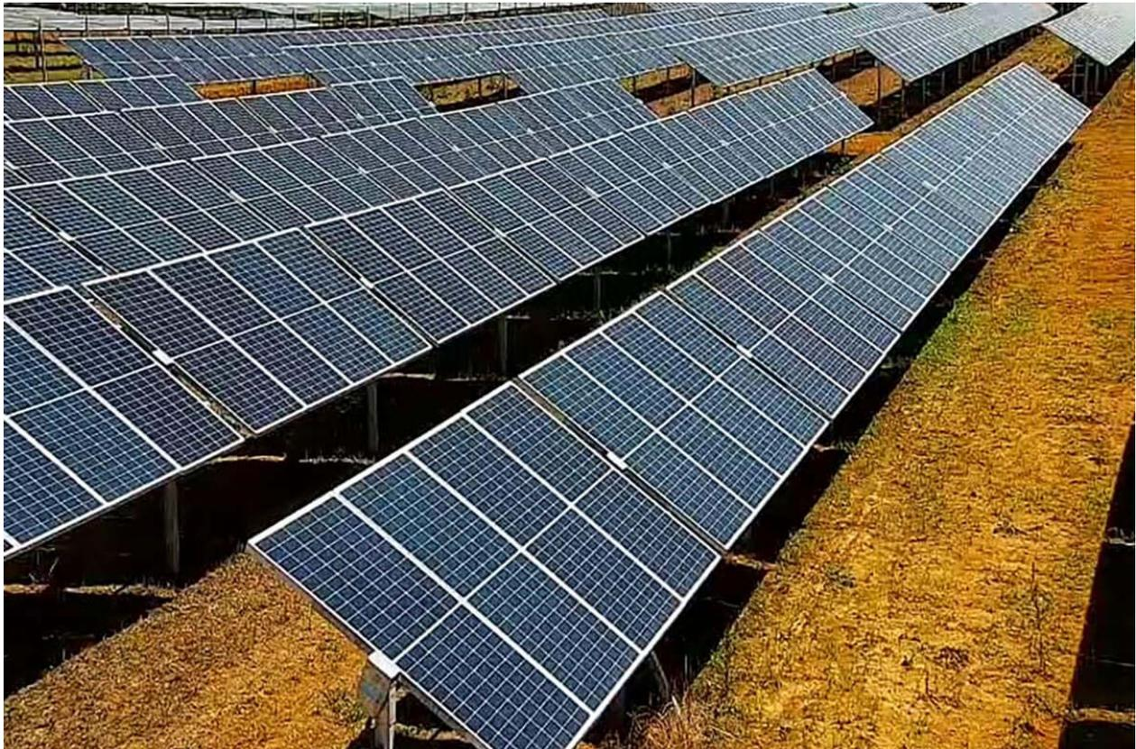
*FIGURA 5 – INSTALLAZIONE SU INSEGUITORE MONO ASSIALE CON DOPPIO MODULO*
