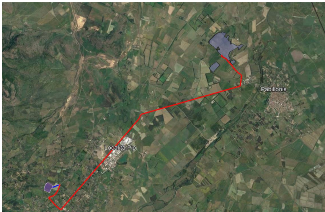
Fig. 5– Tracciato cavidotto MT verso SE
