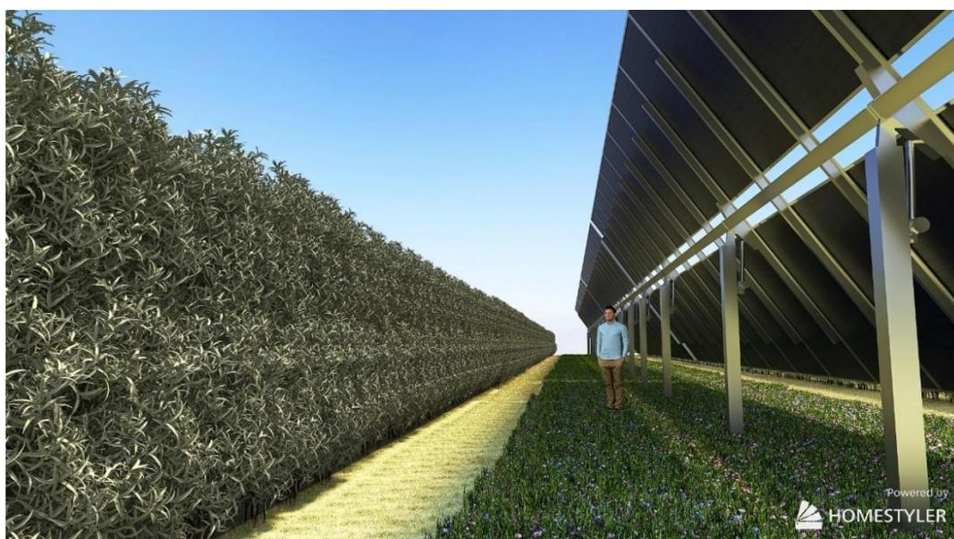
*Figura 87 - Particolare del modello, siepi ulivicole e tracker in posizione verticale*
