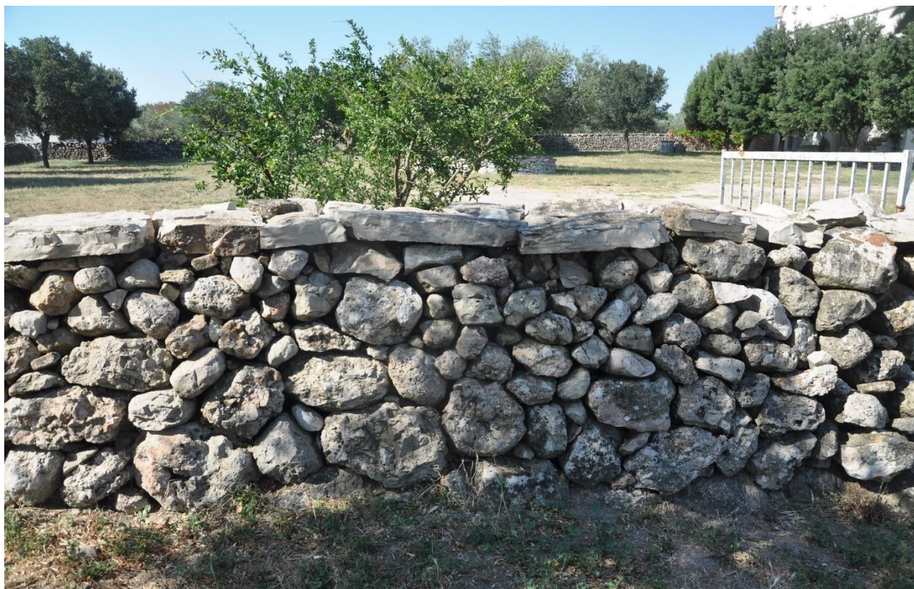
Figura 38 - Muretto a secco del recinto lato sinistro del cancello e corte della villa del proprietario
