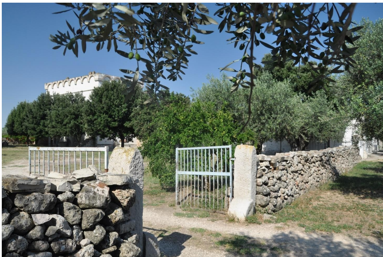
Figura 37 - Accesso al cortile della villa con cancello in ferro e pilastri monoblocchi in pietra
