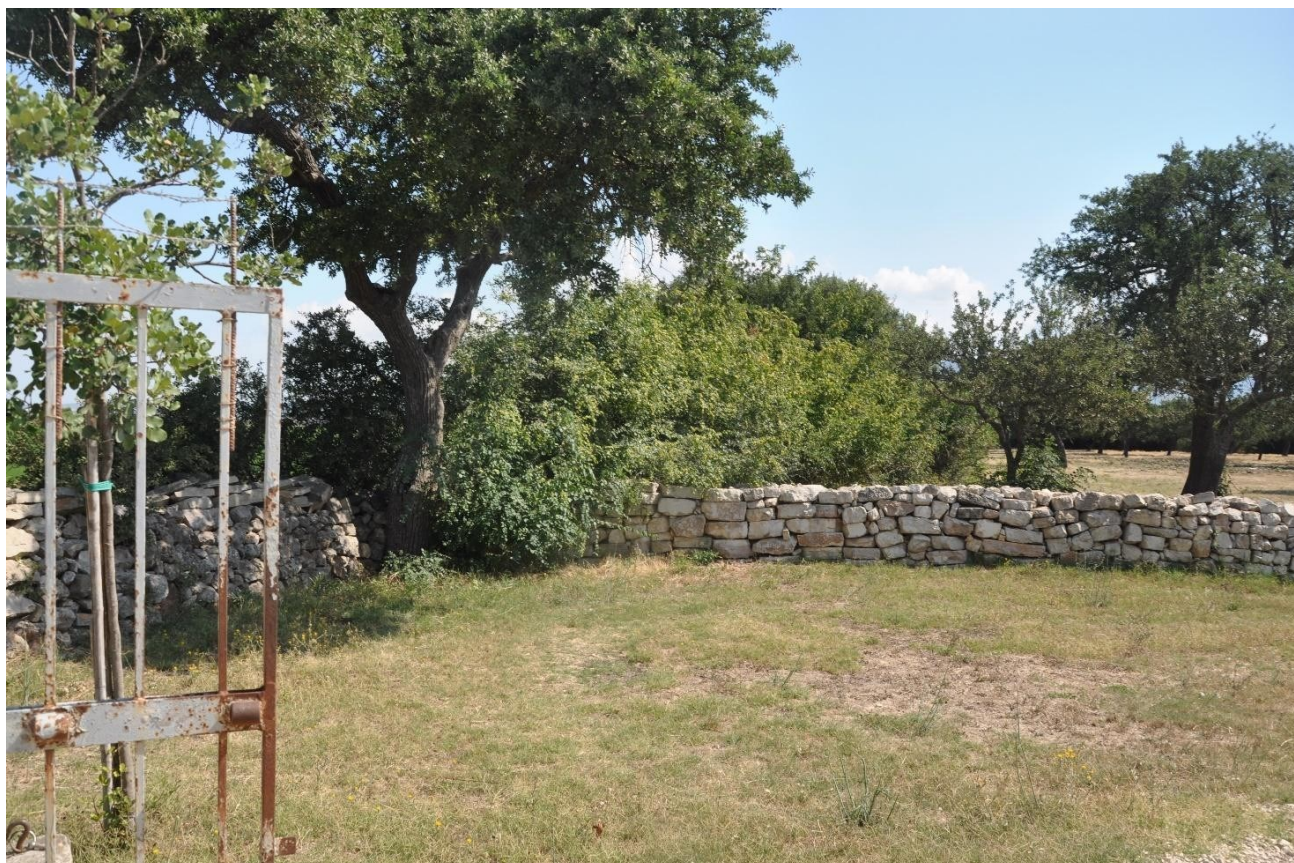
Figura 28 - Muro a secco di recinzione
