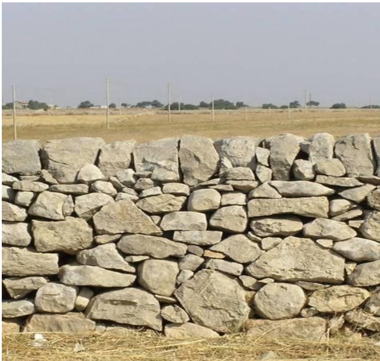
Figura 35 - Particolare di un muretto a secco
