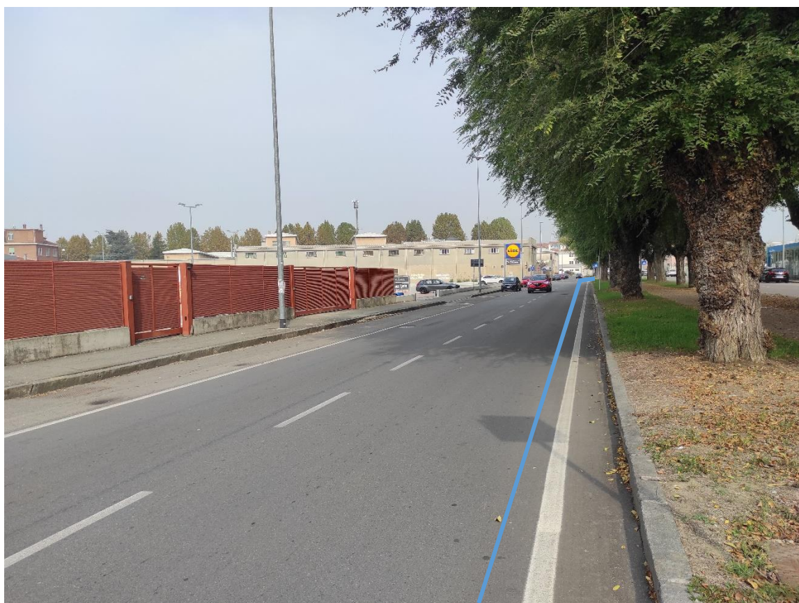
Figura 2. Via S. Giovanni Bosco - Posa linea elettrica su strada asfaltata
