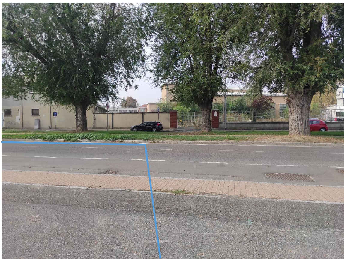
Figura 4. Via S. Giovanni Bosco - Posa linea elettrica su strada asfaltata
