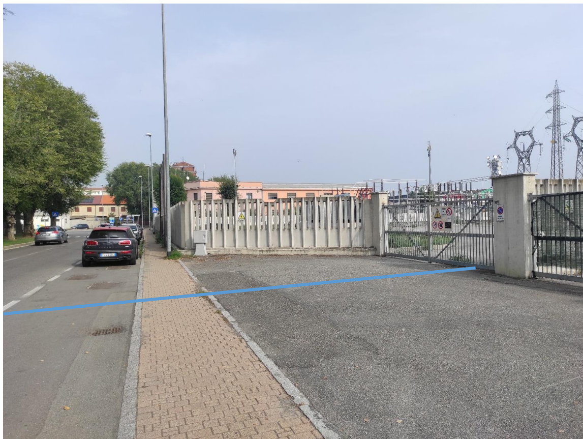
Figura 5. Cabina primaria AT/MT Alessandria Sud
