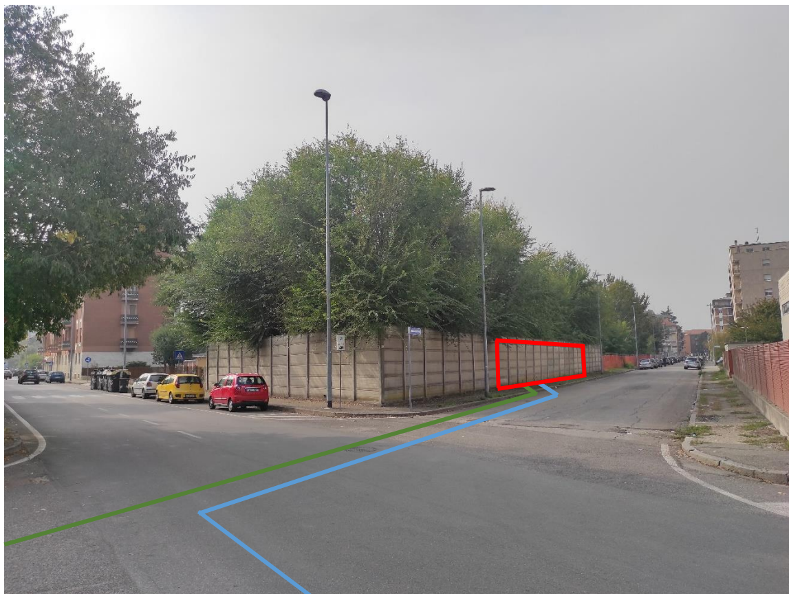
Figura 1. Via Giovanni de Negri - Posa linea elettrica su strada asfaltata
