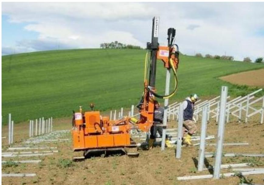
Figura 15 – Esempio di macchina battipalo usata per l'installazione di pannelli fotovoltaici
