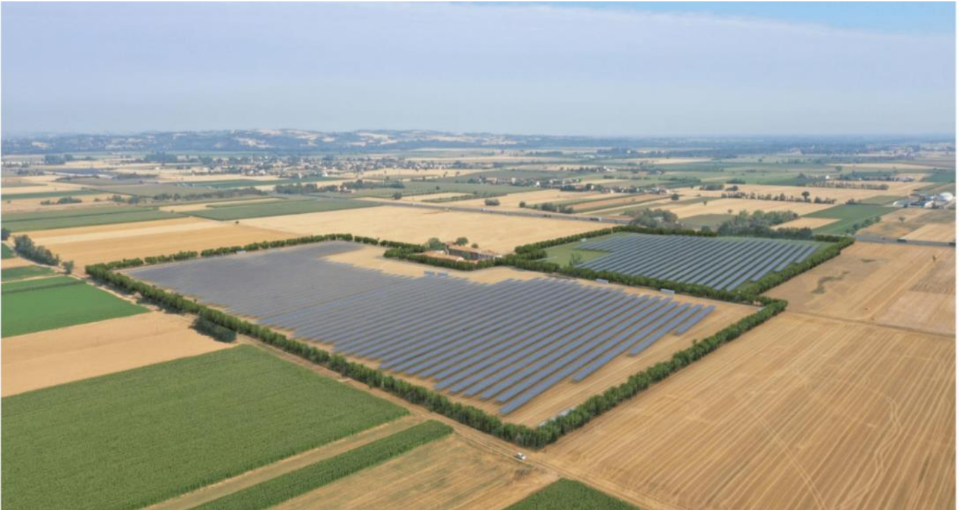
Figura 16 - Foto-inserimento del parco con ripresa aerea dal lato Sud-Est (da elaborati di progetto)
