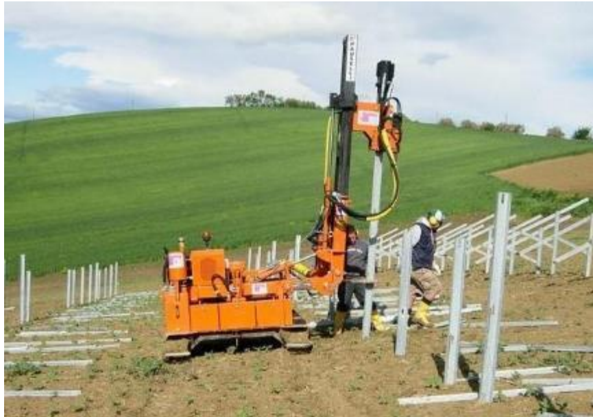
Figura 8 – Esempio di macchina battipalo usata per l'installazione di pannelli fotovoltaici
