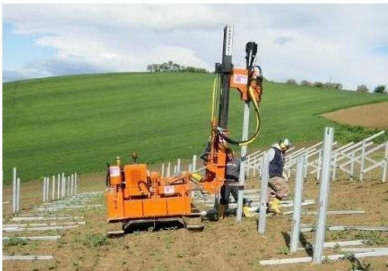
Figura 14 – Esempio di macchina battipalo usata per l'installazione di pannelli fotovoltaici
