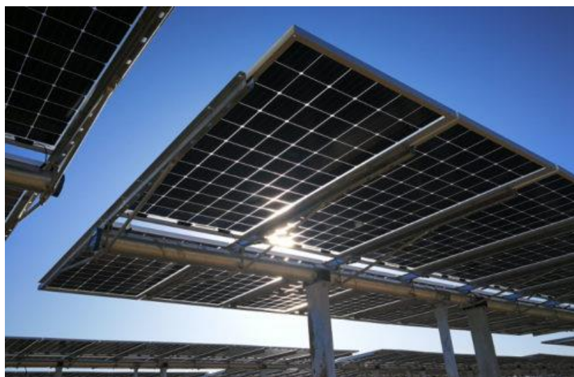
Figura 3.4 Esempio di struttura a tracker monoassiale
