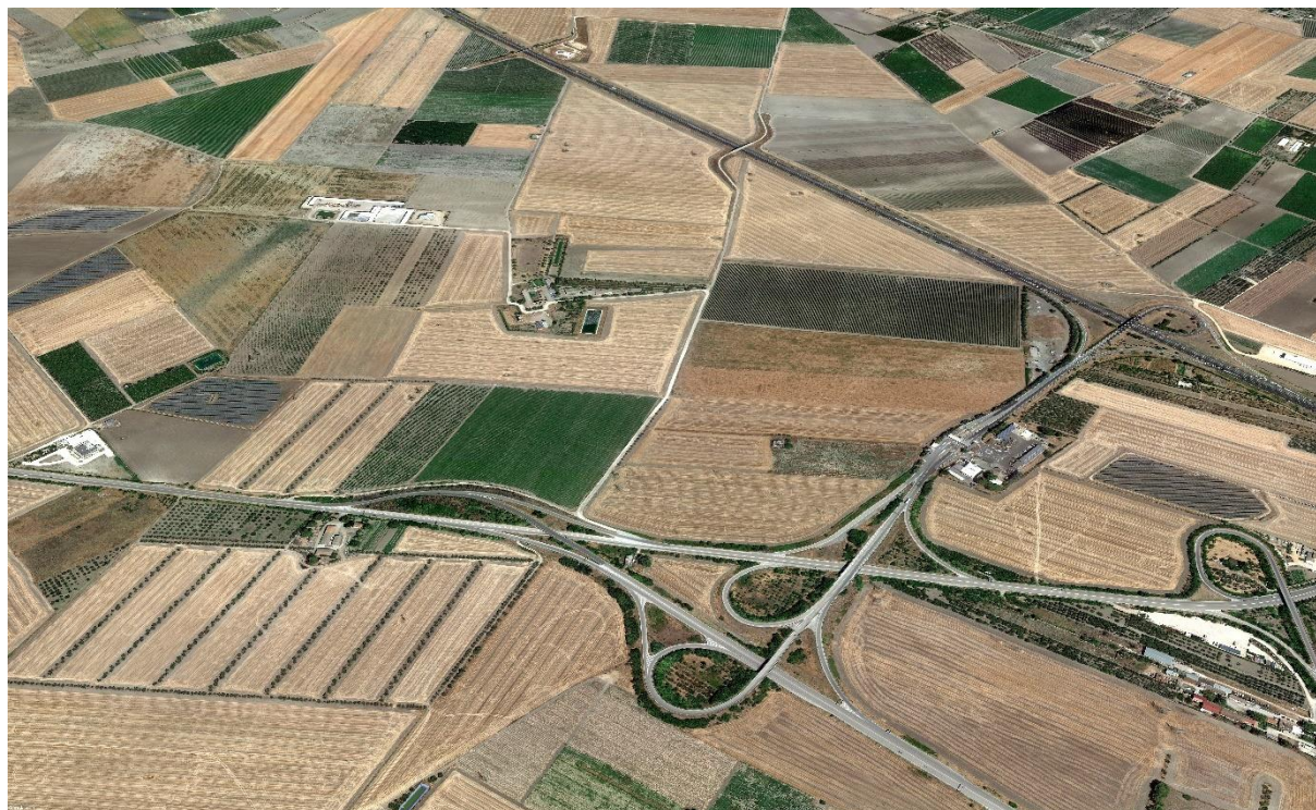
Figura 5.5: Vista Aerea Area Centro – Stato di Fatto
