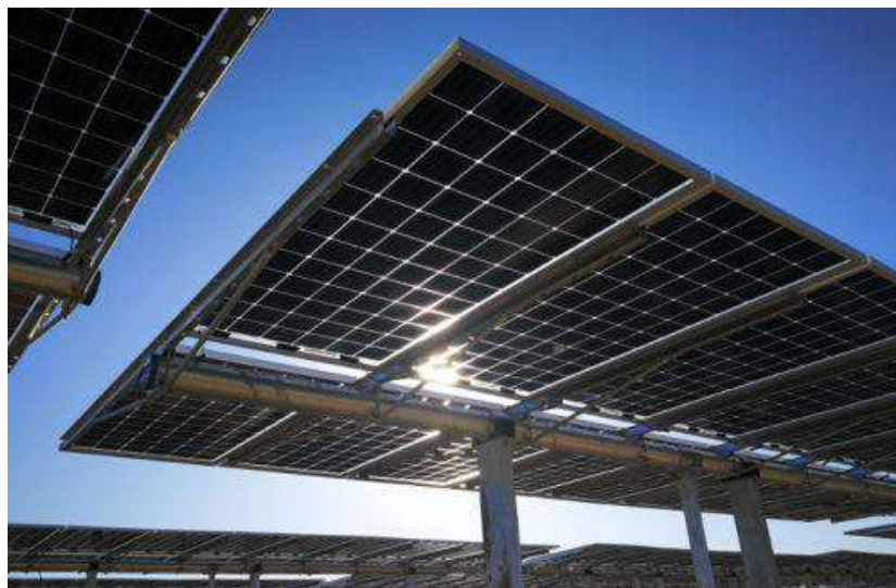
Figura 2.48 Esempio di struttura a tracker monoassiale
