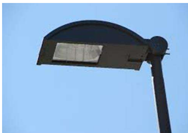
Figura 4.51: Esempio di apparecchio completamente schermato (full-cut-off)
