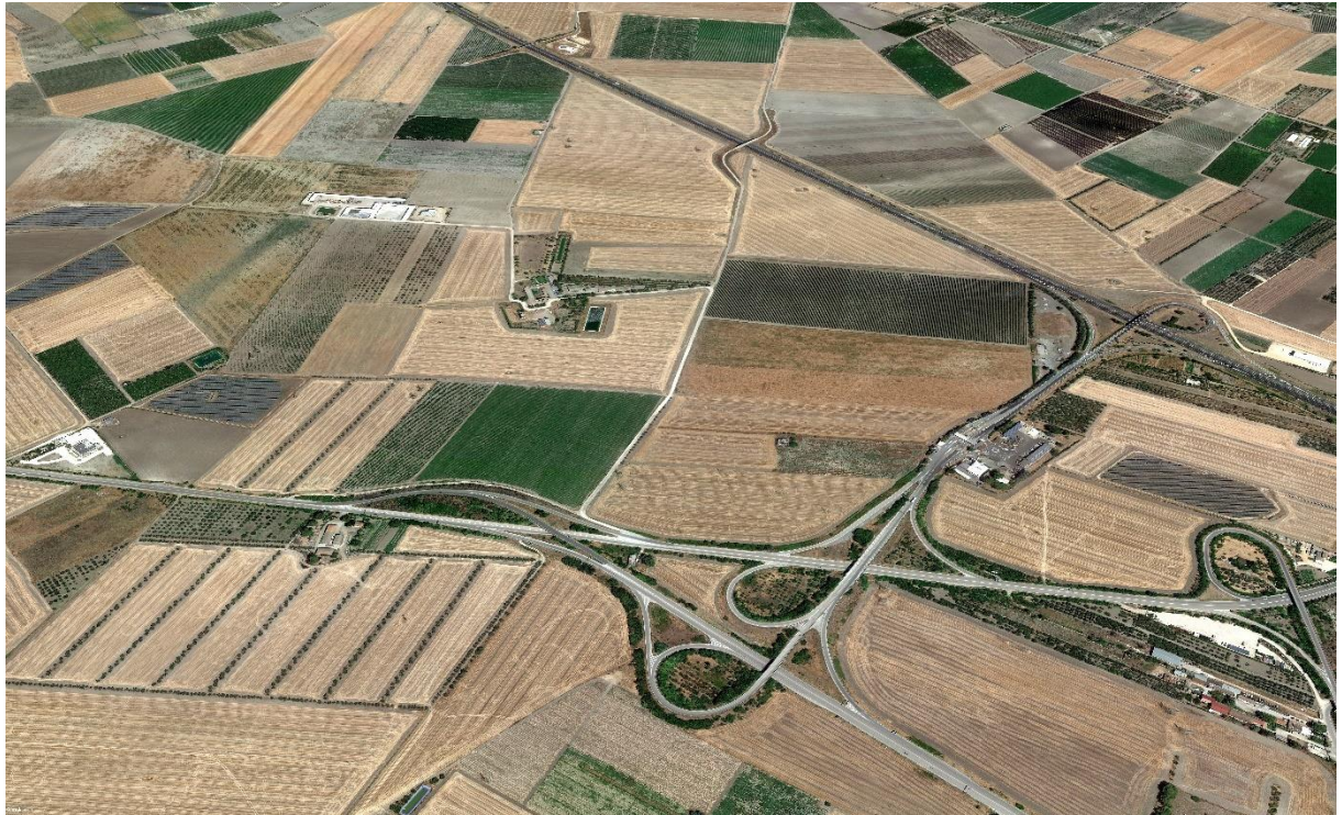
• Figura 5.7: Vista Aerea Area Centro – Stato di Fatto
