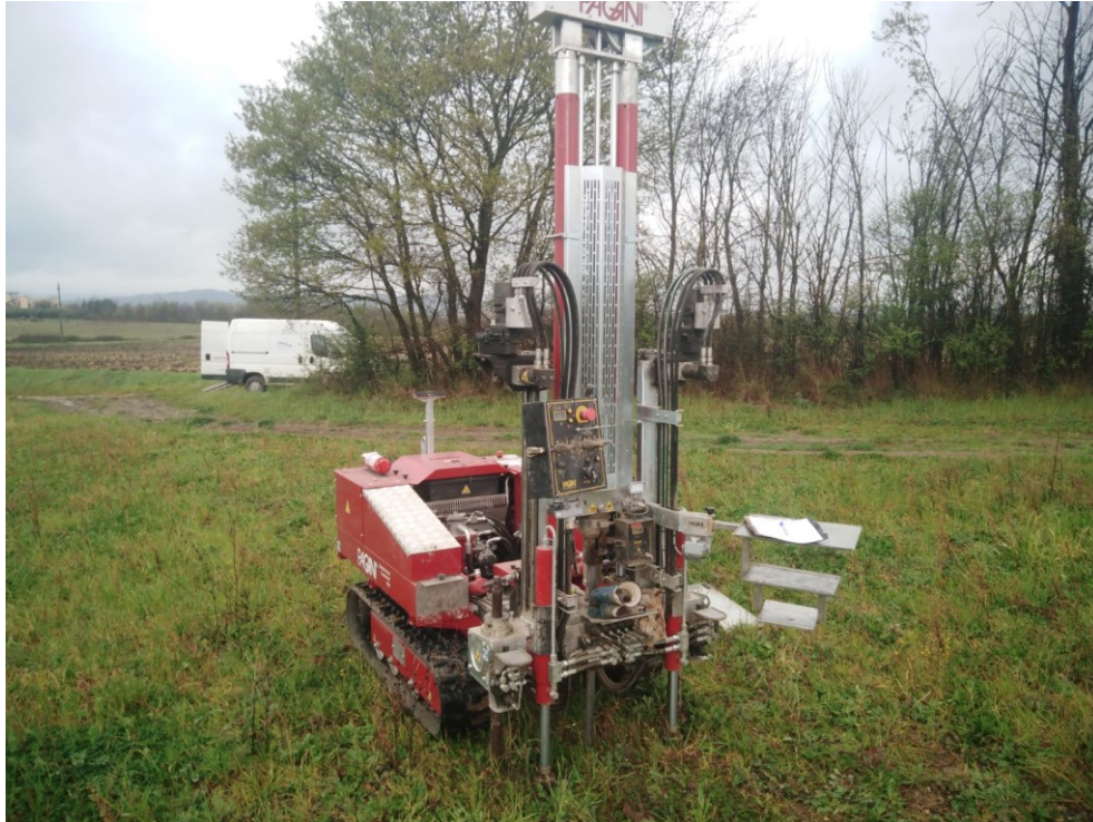
Prova Penetrometrica Statica CPT 01 – Impianto Fotovoltaico
