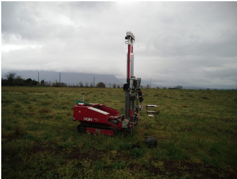
Prova Penetrometrica Statica CPT 04 – Impianto Fotovoltaico
