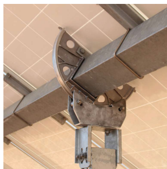
Figura 3. Schema nodo trave continua / colonna
