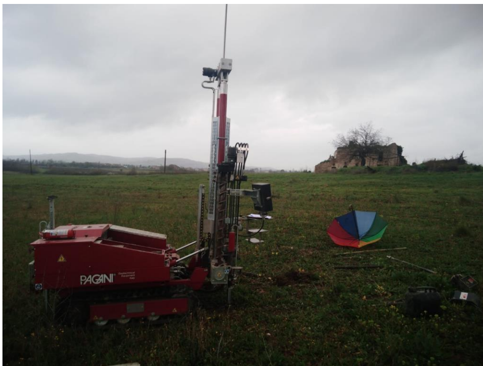
Prova Penetrometrica Dinamica Pesante DPSH 02 – Impianto Fotovoltaico
