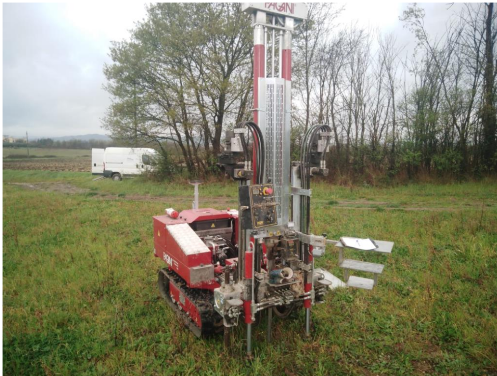
Prova Penetrometrica Statica CPT 01 – Impianto Fotovoltaico
