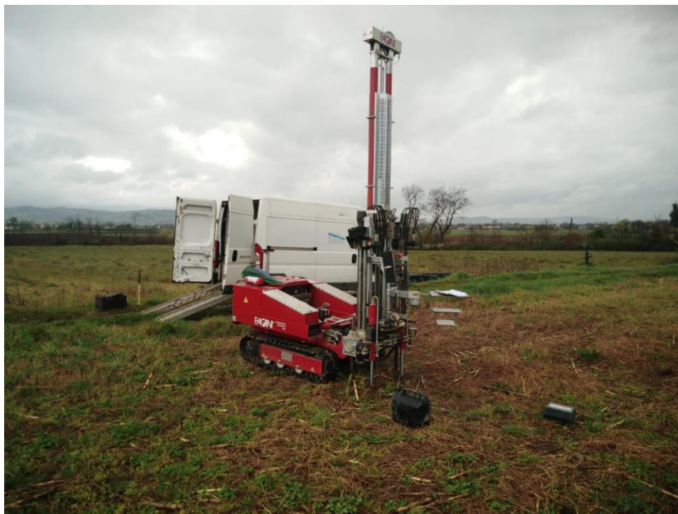
Prova Penetrometrica Statica CPT 03 – Impianto Fotovoltaico
