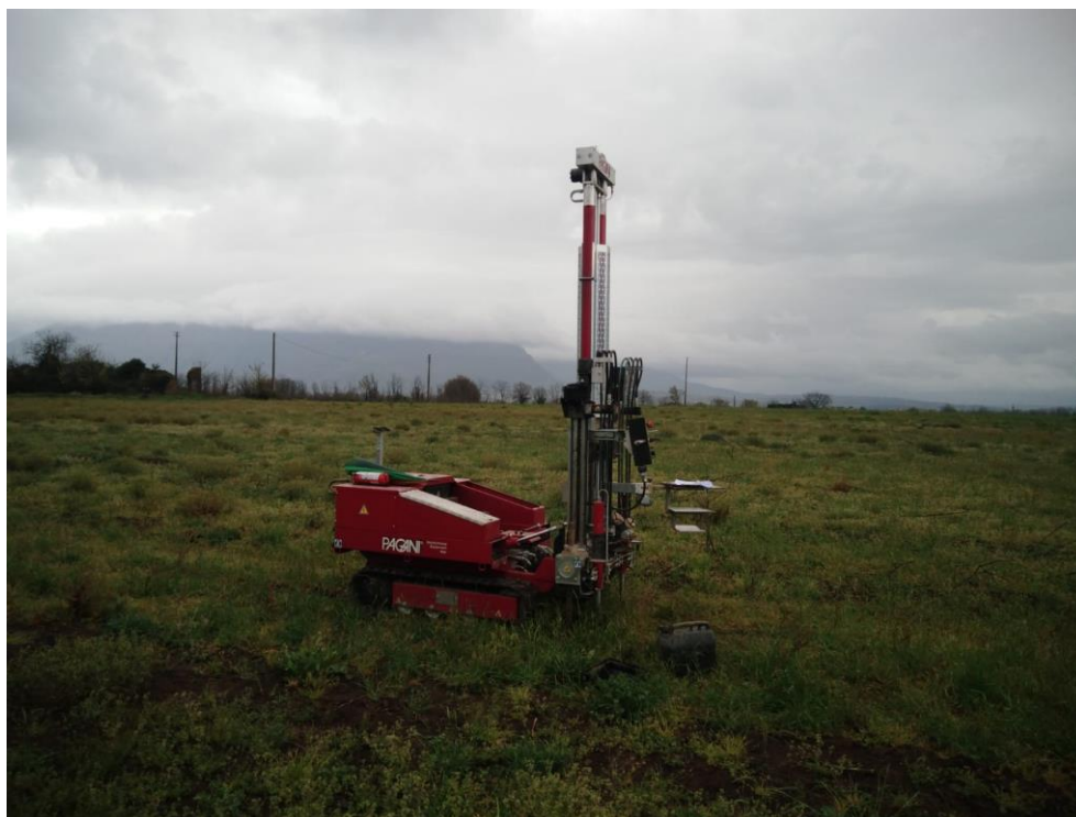
Prova Penetrometrica Statica CPT 04 – Impianto Fotovoltaico
