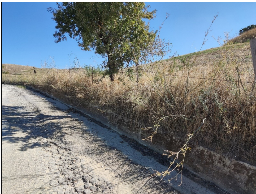
Fig. 16: strada provinciale in prossimità dell'impianto
